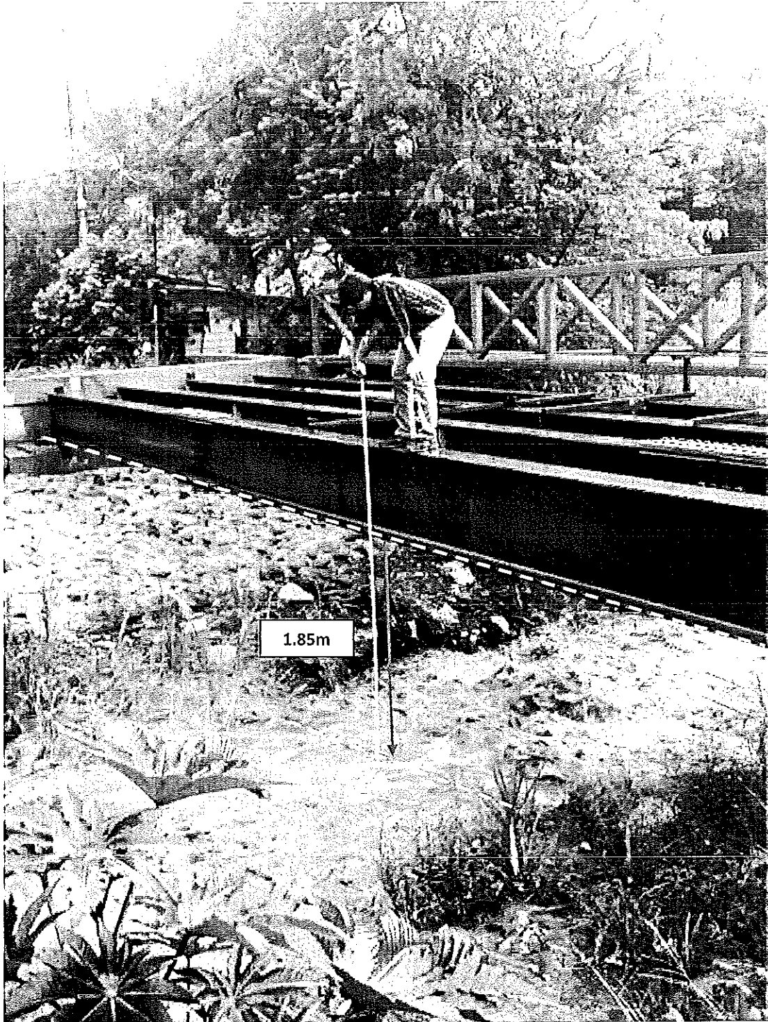
Figura 2: Medición de altura libre vertical en Puente La Cañada Fuente: Visita LanammeUCR 4-06-2013
