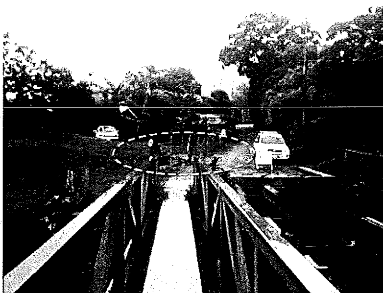
Figura 3: Presencia de entradas en la zona de los accesos al puente Fuente: Visita LanammeUCR 4-06-2013
