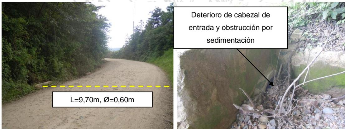
**Figura N°8. Paso de alcantarilla transversal Est 17+020.**
