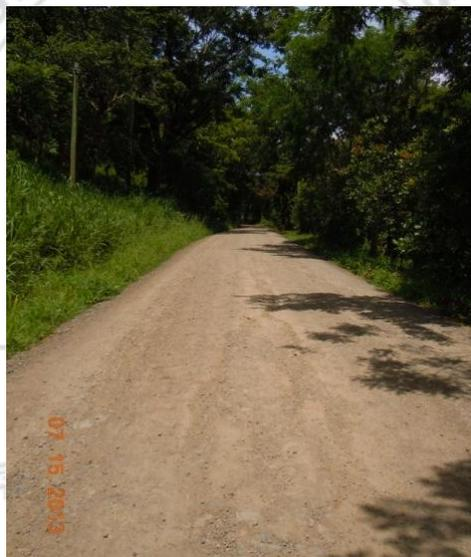
**Fotografía N°3. Posibilidad de ampliación de la calzada para zona de refugio (Estacionamiento 7+790).**
