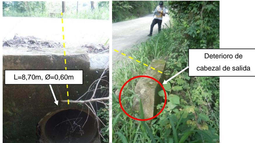
**Figura N°6. Paso de alcantarilla transversal Est 8+080.**
