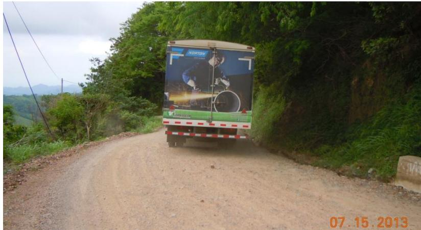
**Fotografía N°2. Sección angosta con un derecho de vía aproximadamente de 7 m, con ausencia de protección lateral (Entre estacionamiento 13+550 y 13+600).**
