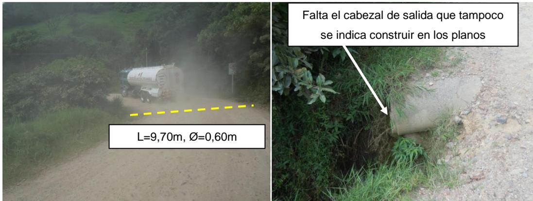
**Figura N°9. Paso de alcantarilla transversal Est 19+750.**
