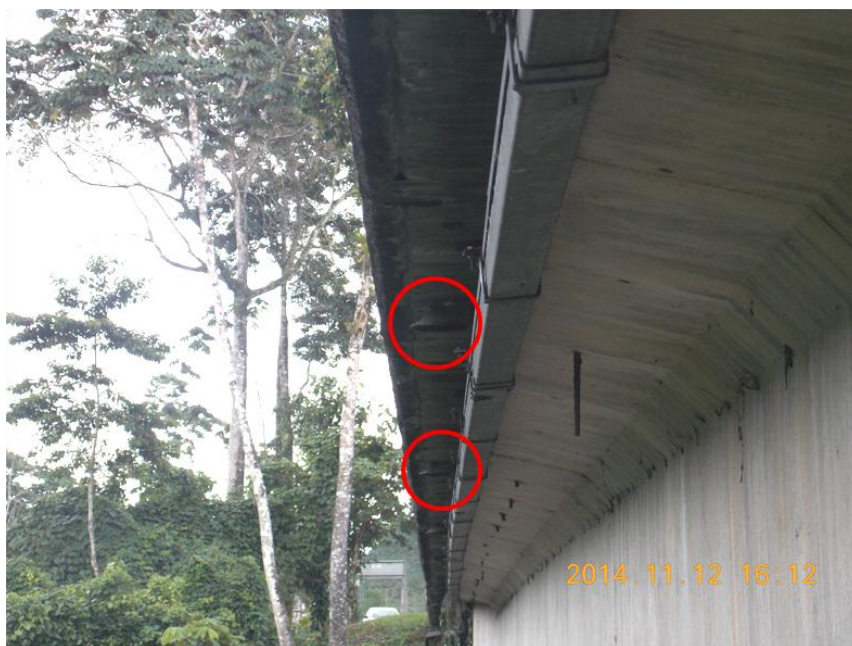
Figura 6. Longitud insuficiente de los ductos de drenaje de la superestructura.
