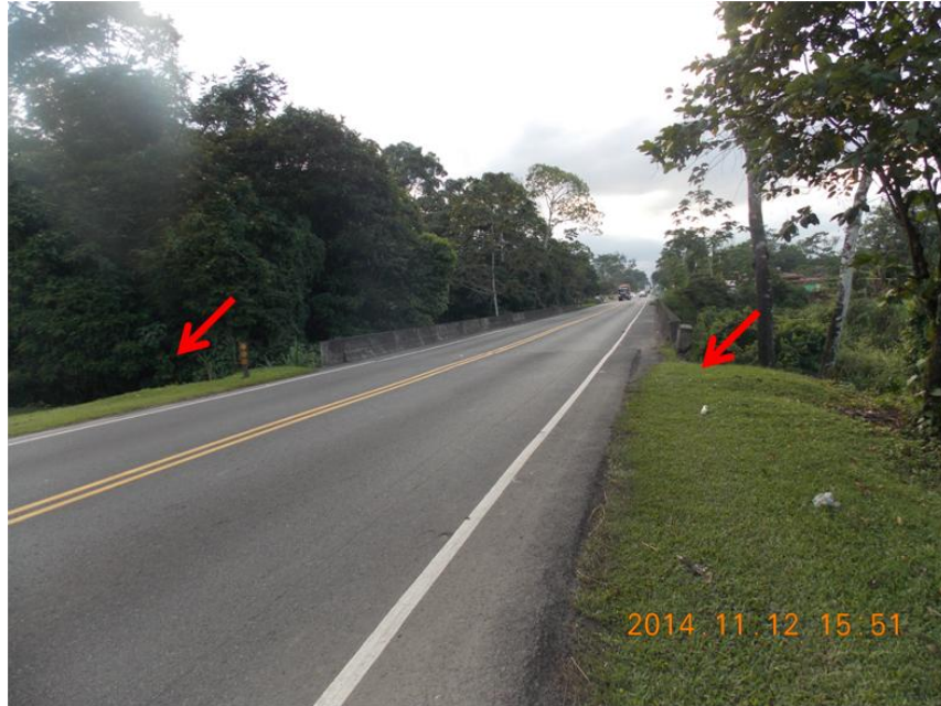
Figura 1. Ausencia de guardavías, rótulos de identificación y marcador de objeto en el costado derecho en el acceso 1.
