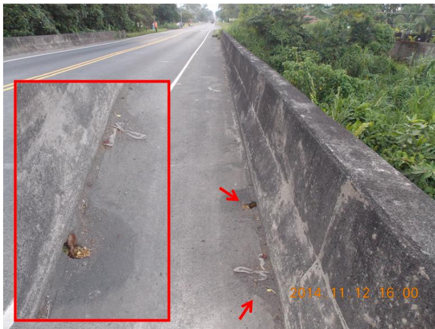
Figura 5. Acumulación de sedimentos y basura en los bordillos y los ductos de drenaje de la superestructura.
