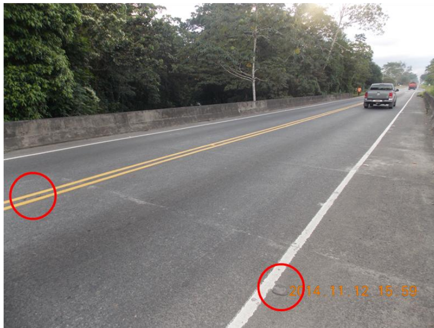
Figura 2. Desprendimiento de captaluces en la calzada.
