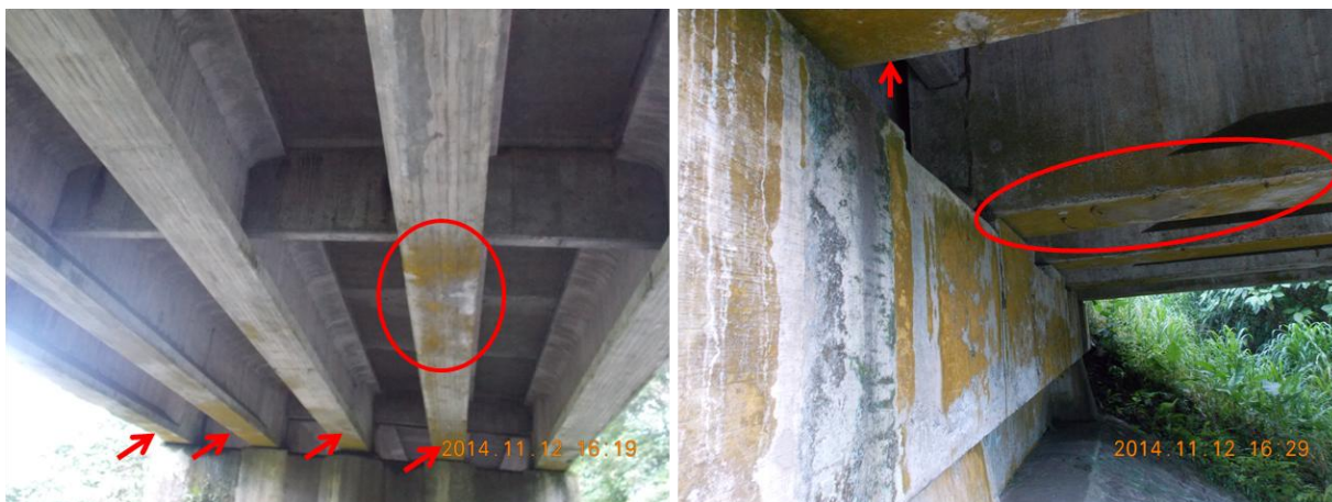
Figura 13. Manchas de humedad en la superficie inferior de las vigas principales en las proximidades de la pila y el bastión 1.
