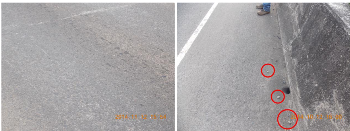
Figura 4. Desgaste superficial y leve desprendimiento de agregado en la superficie de rodamiento.
