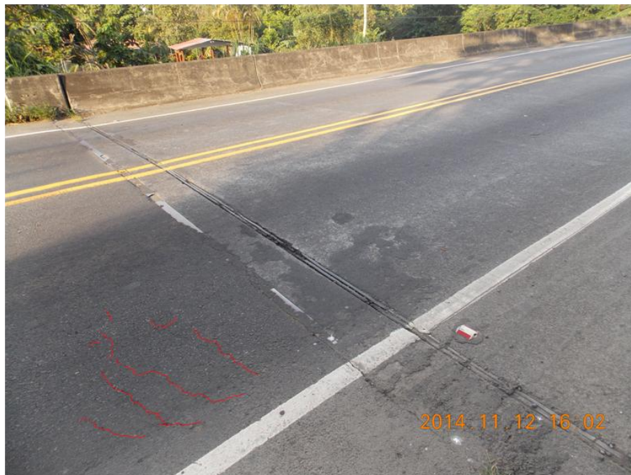
Figura 10. Grietas en la superficie de rodamiento del acceso de aproximación 2.
