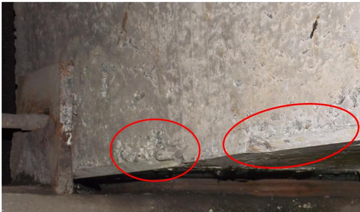
Figura 12. Nidos de piedra en vigas principales.
