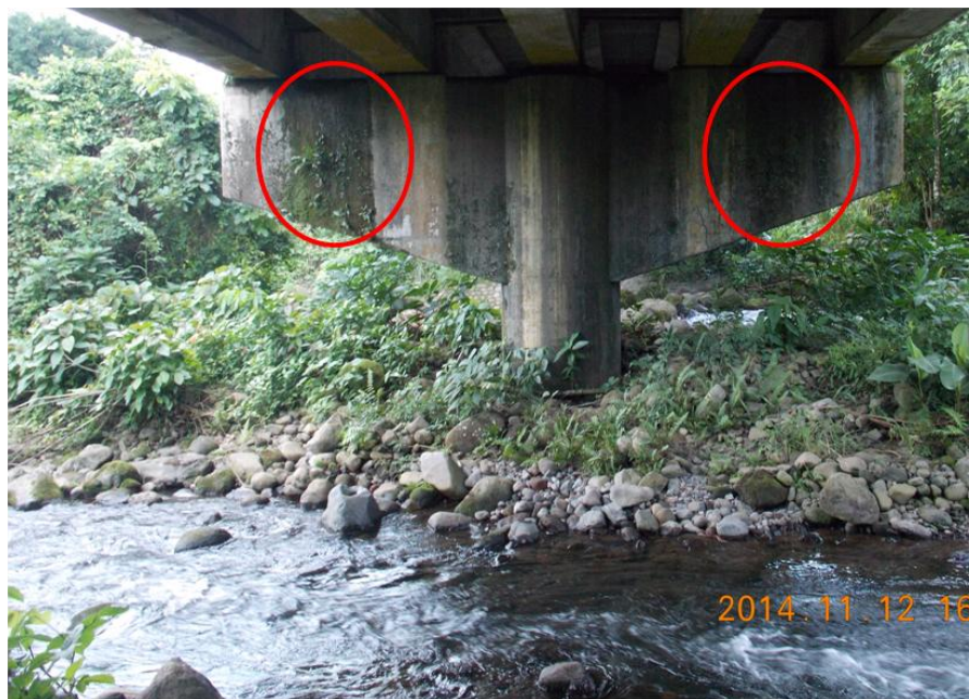
Figura 17. Manchas de humedad en la viga cabezal de la pila.
