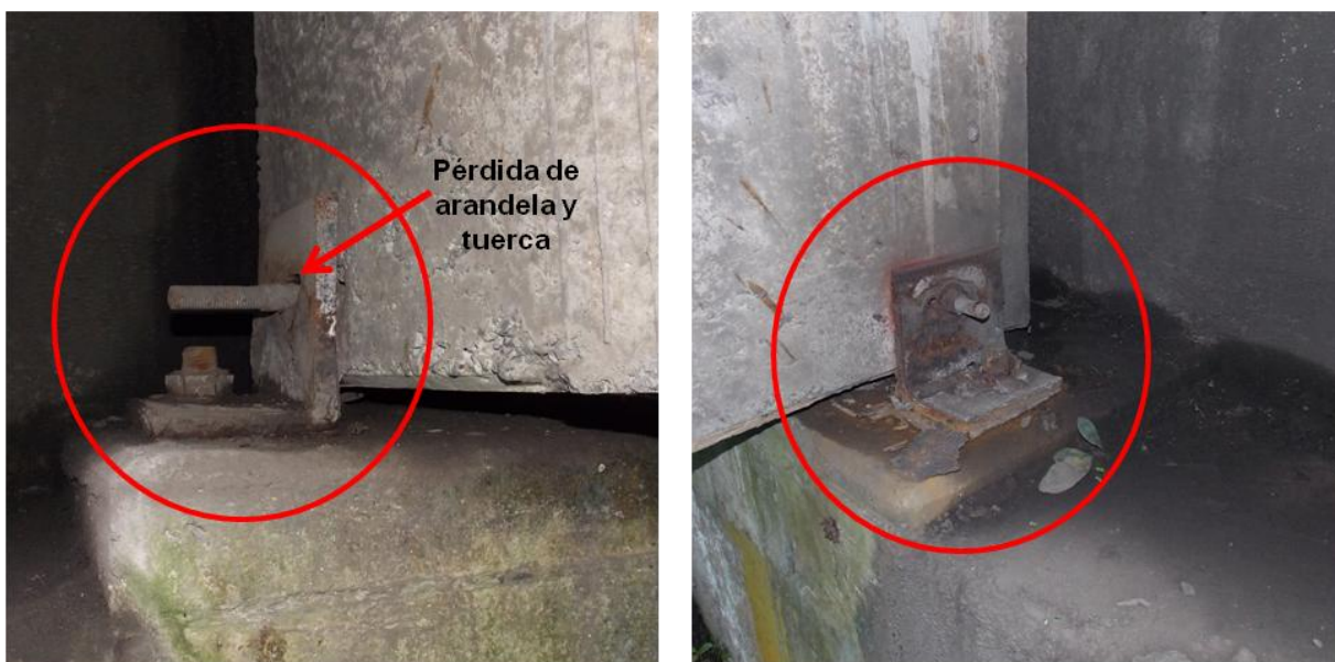
Figura 14. Corrosión del mecanismo de anclaje de los apoyos y pérdida de arandela y tuerca.
