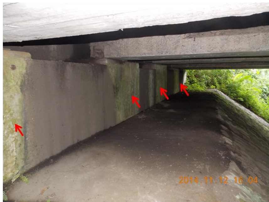
Figura 16. Manchas de humedad en la viga cabezal del bastión 2
