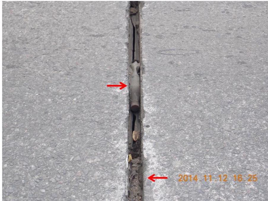
Figura 9. Presencia de basura y sedimentos en la junta de expansión.
