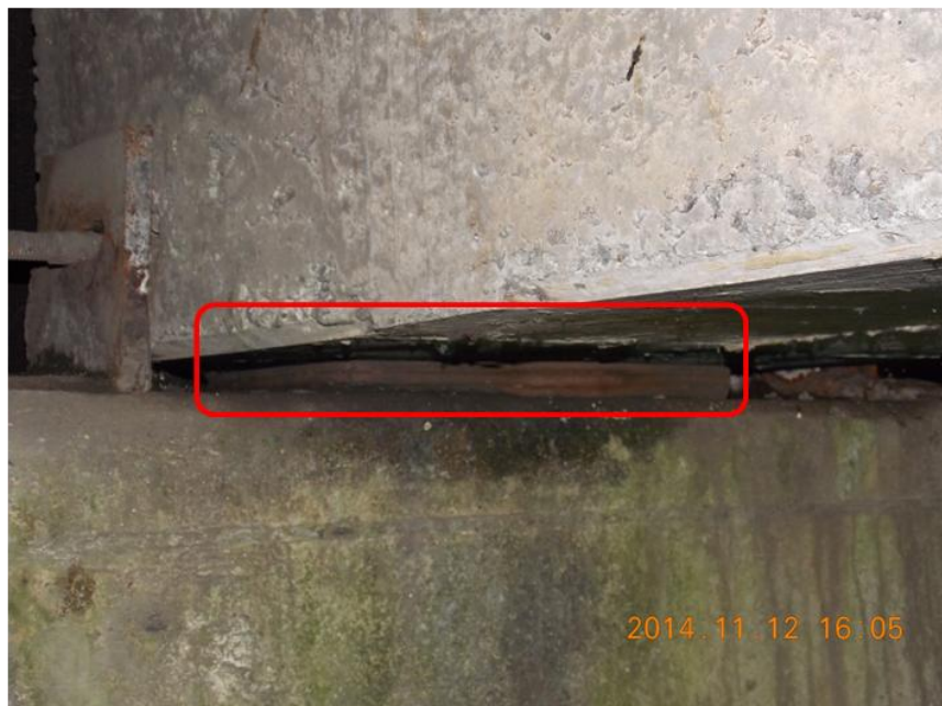
Figura 15. Degradación de las almohadillas de neopreno de los apoyos.
