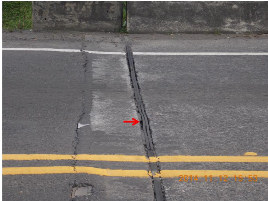
Figura 7. Deformación del sello de las juntas de expansión en los extremos del puente.
