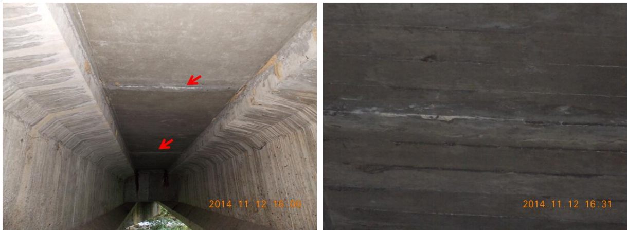
Figura 11. Eflorescencia en las juntas de construcción de la losa de concreto.
