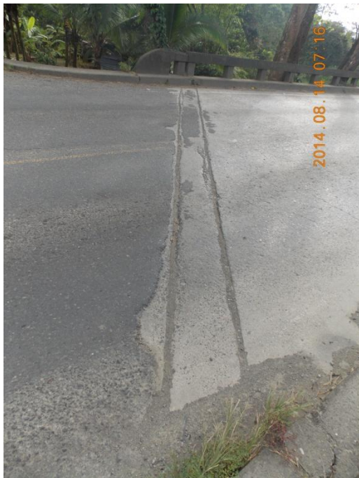
(a) Junta de expansión entre bastión 2 y superestructura 3
