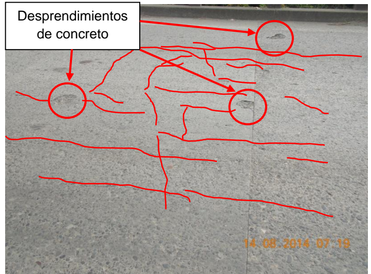
(b) Losa de Superestructura 2
