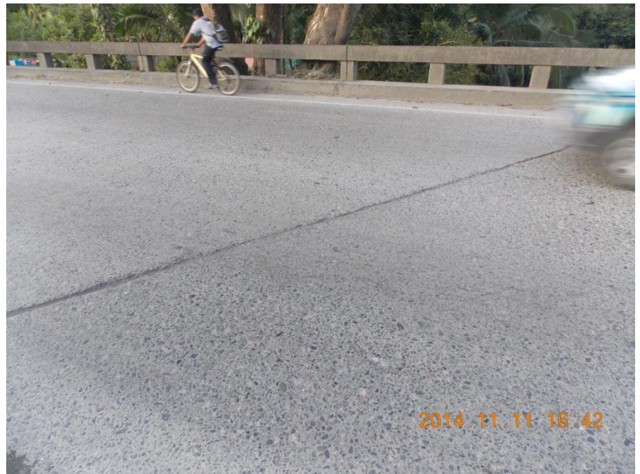
(b) Junta de expansión entre las superestructuras 2 y 3
