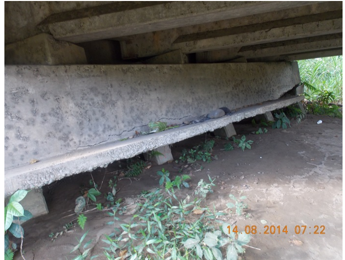
(b) Inspección de agosto de 2014
