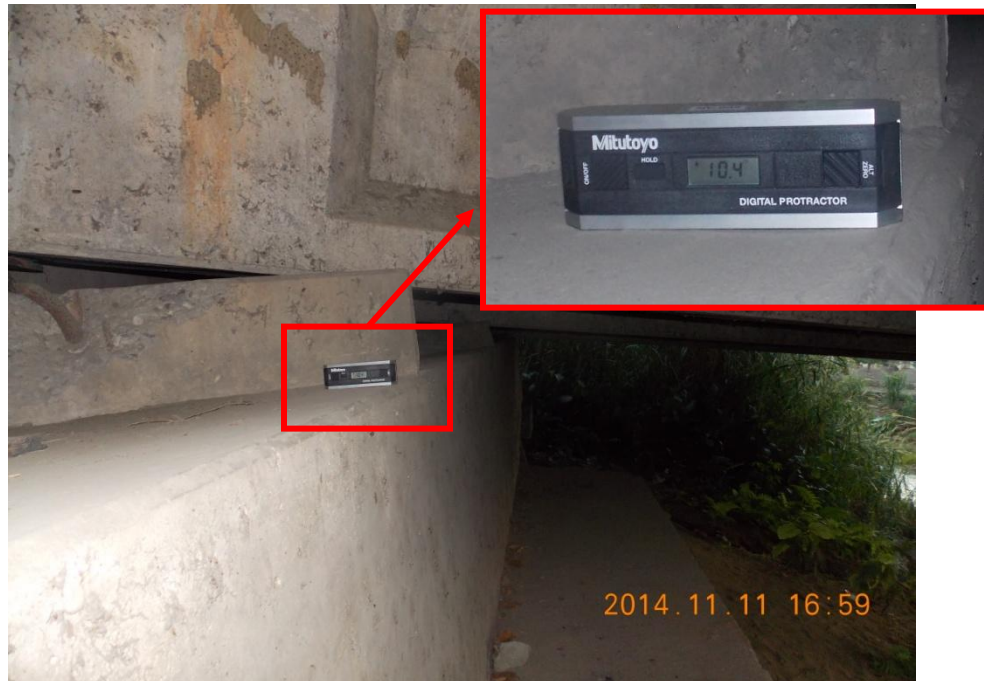
Figura 17: Inclínación del bastión 1 medida con nivel de precisión.
