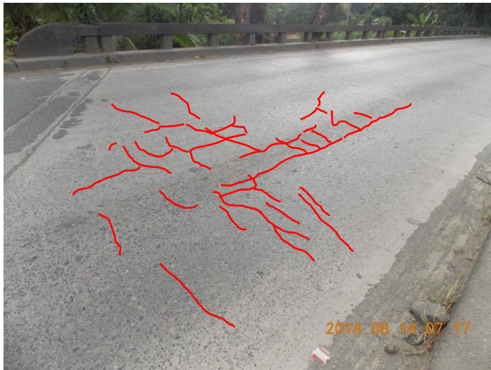
(a) Losa de Superestructura 3
