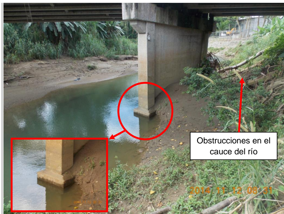
Figura 20: Pila 2 con sección inferior expuesta debido a erosión provocada por el río Blanco.
