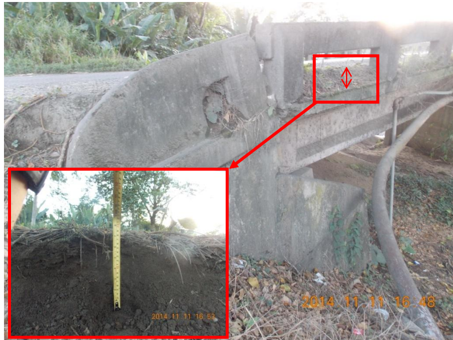
Figura 5: Sobrecapa de aproximadamente 0,25 m sobre el bordillo de seguridad del puente.
