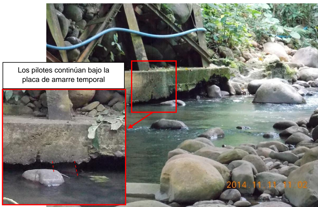
Figura 15: Socavación bajo la placa colocada como amarre temporal del sistema de pilotes de la fundación.
