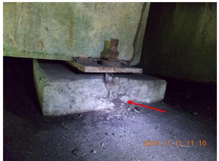
(b) Desprendimientos de concreto en pedestal de apoyo sobre bastión 2
