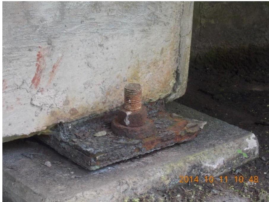
Figura 10: Corrosión en los elementos metálicos de los apoyos del puente.
