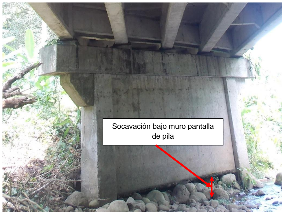
Figura 16: Socavación por debajo del muro pantalla de la pila 1.
