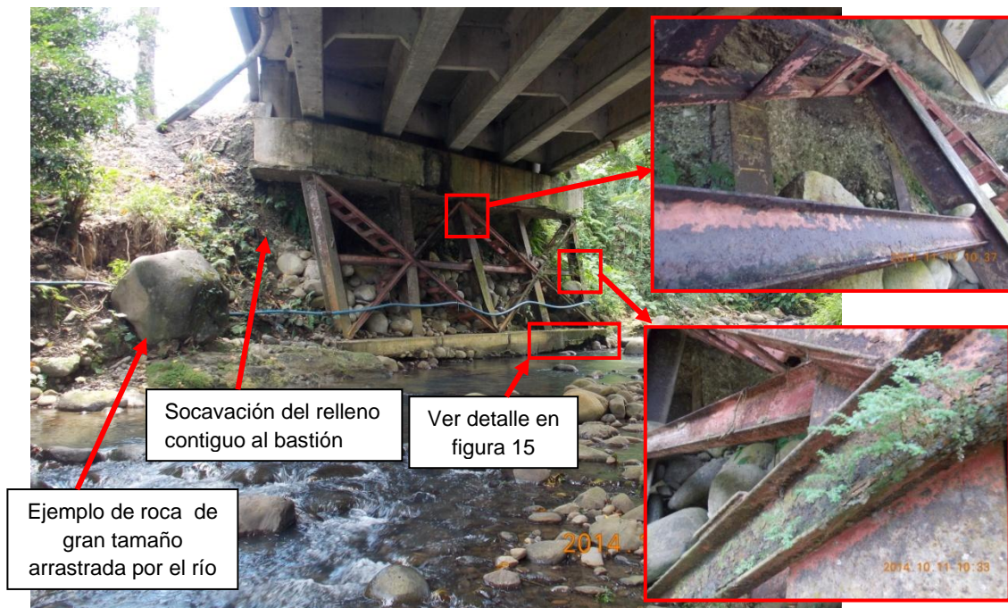
Figura 14: Socavación de la fundación del bastión 1, con pilotes expuestos. Se muestra además corrosión de los pilotes y del sistema de arriostramiento temporal.
