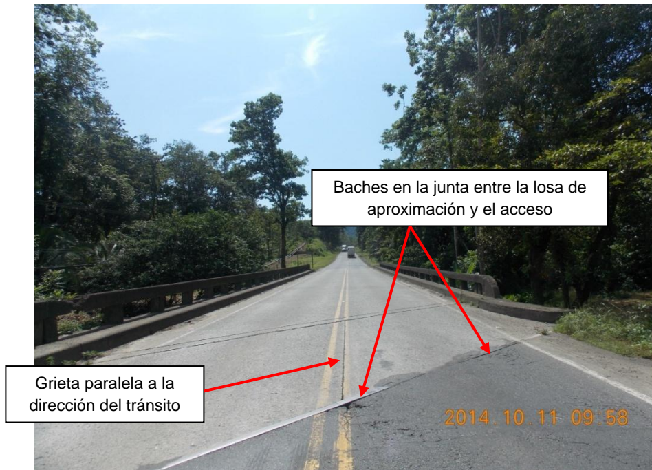
Figura 6: Grieta en la losa de aproximación del acceso 2 y baches en la junta entre la losa y el pavimento del acceso.
