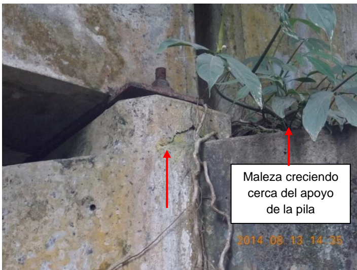
(a) Grietas en pedestal de apoyo sobre la pila 1 y maleza en las cercanías de los apoyos.
