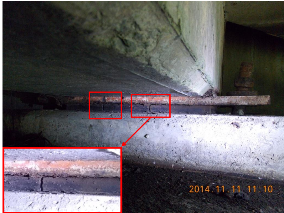
Figura 12: Grieta vertical en material elastomérico de los apoyos.
