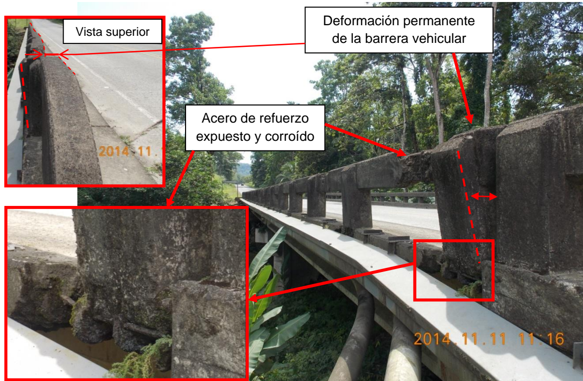
Figura 2: Deformación permanente de la barrera noreste cerca del acceso 2 y desprendimientos de concreto con acero de refuerzo expuesto y corroído.
