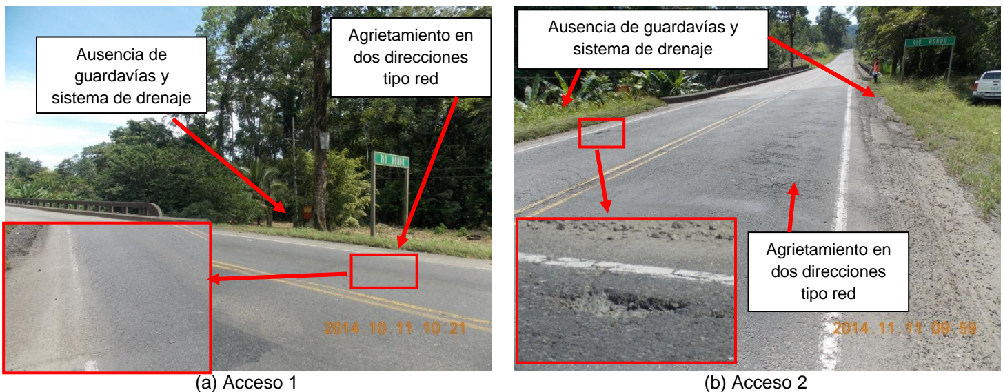
Figura 5: Agrietamiento en la carpeta asfáltica de ambos accesos, ausencia de guardavías y de sistema de drenaje.
