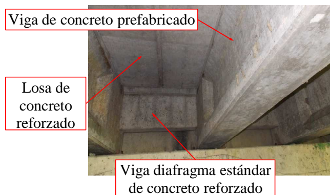
Figura 1.- Práctica estándar de vigas diafragma de concreto colado en sitio.
