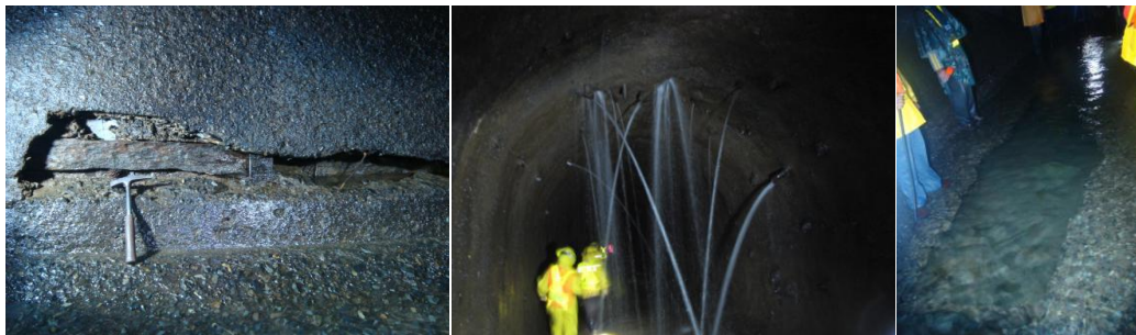
FIGURA 15. Imágenes del estado del Túnel de Río Macho, en la inspección de junio de 2010.
