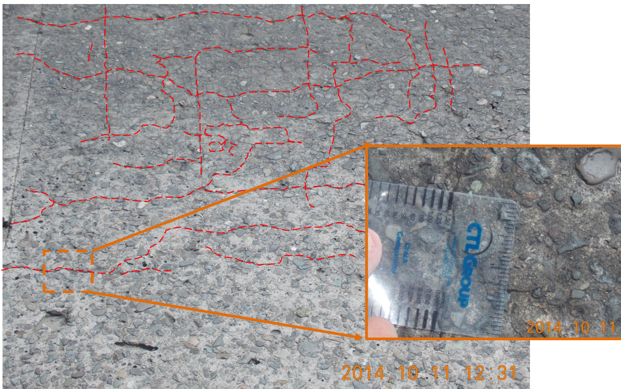
Figura 3: Agrietamiento en dos direcciones de en la cara superior de la losa.
