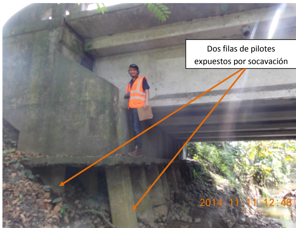
Figura 8: Socavación al margen derecho de la quebrada, cimiento bastión 1.
