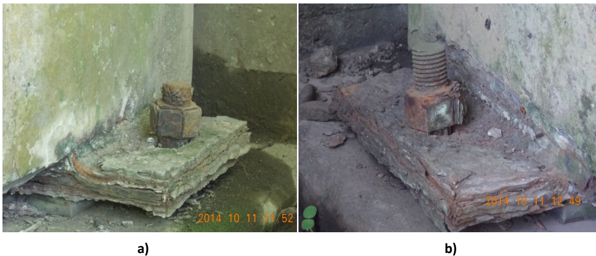
Figura 15: Corrosión con pérdida de sección en los elementos metálicos de los apoyos; a) apoyo expansivo sobre bastión 2, b) apoyo fijo sobre bastión 1.
