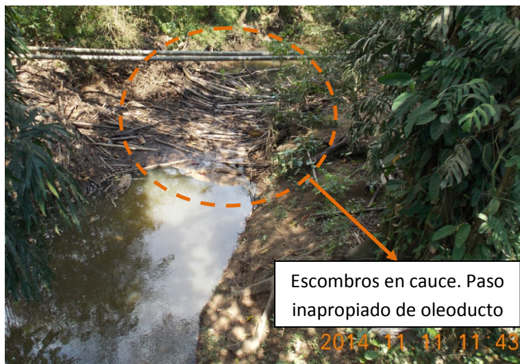
Figura 9: Obstrucción por troncos en el cauce de la quebrada.
