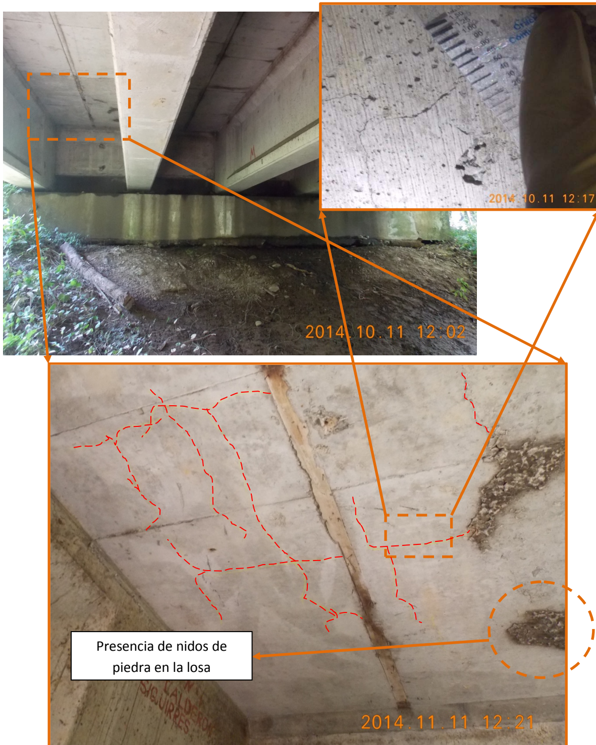
Figura 11: Agrietamiento en dos direcciones y nidos de piedra en la cara inferior de la losa.
