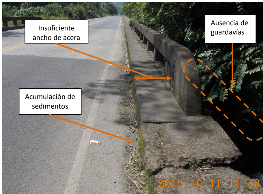
Figura 1: El bordillo no cumple con las condiciones mínimas de acera y esta presenta escombros que obstruyen los drenajes.
