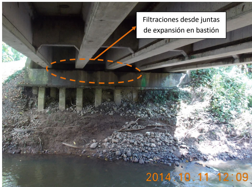
Figura 17: Ausencia de protección de talud y socavación en bastión 1.
