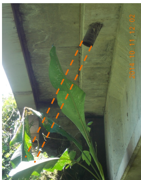
Figura 4: Extensión de tubo insuficiente en salida de drenaje.
