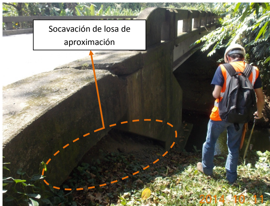
Figura 7: Socavación en losa de aproximación del puente.
