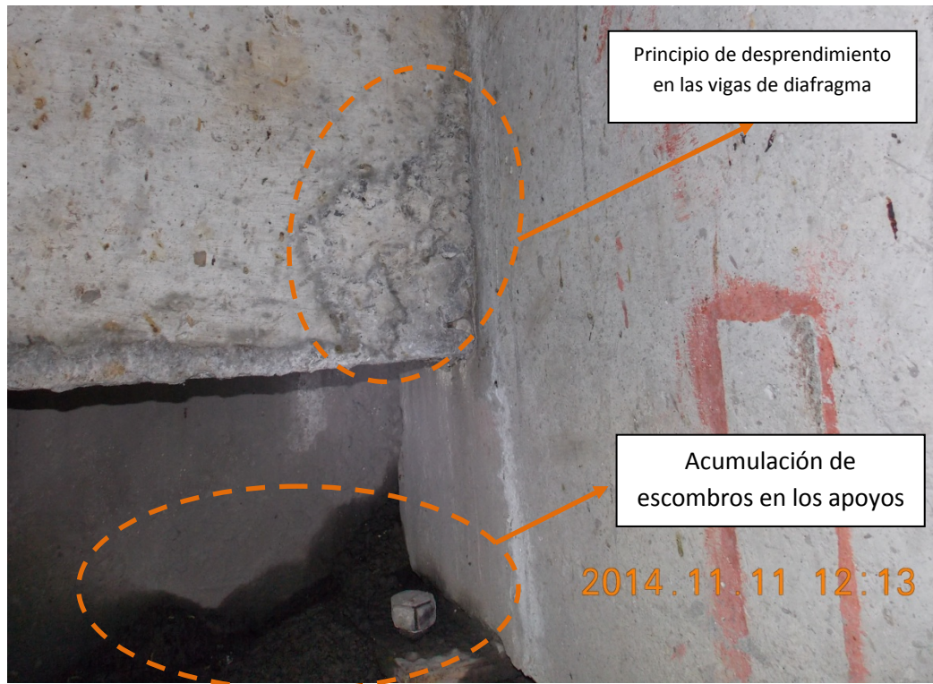
Figura 14: Desprendimiento en la viga diafragma y acumulación de escombros en apoyo.
