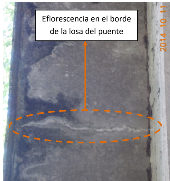
Figura 12: Daño por eflorescencia en la losa del puente.
