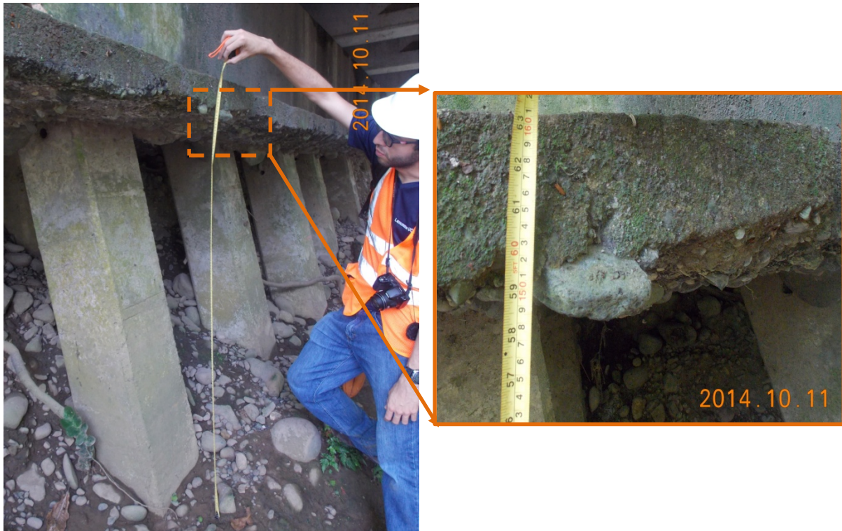
Figura 18: Cimentación expuesta por socavación del margen derecho de la quebrada en el bastión 1.
