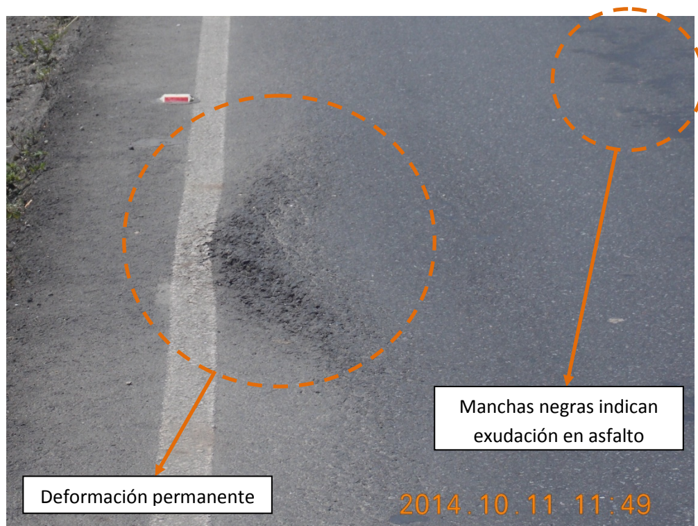
Figura 6: Presencia de deformación permanente y exudaciones en la carpeta asfáltica.
