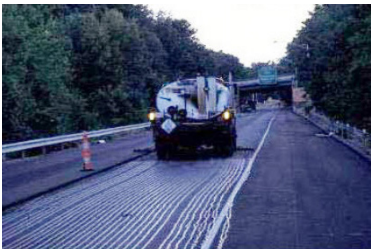
Figura 5. Riego de liga no uniforme en rayas.
