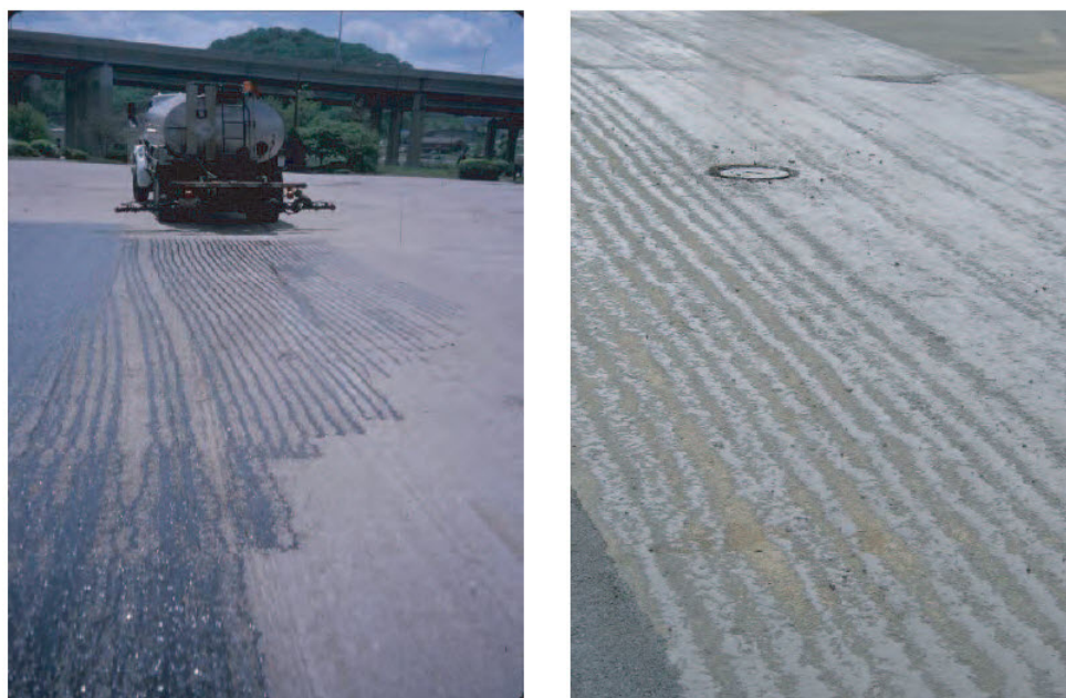
Figura 11. Riego de liga con boquillas parcialmente bloqueadas.
