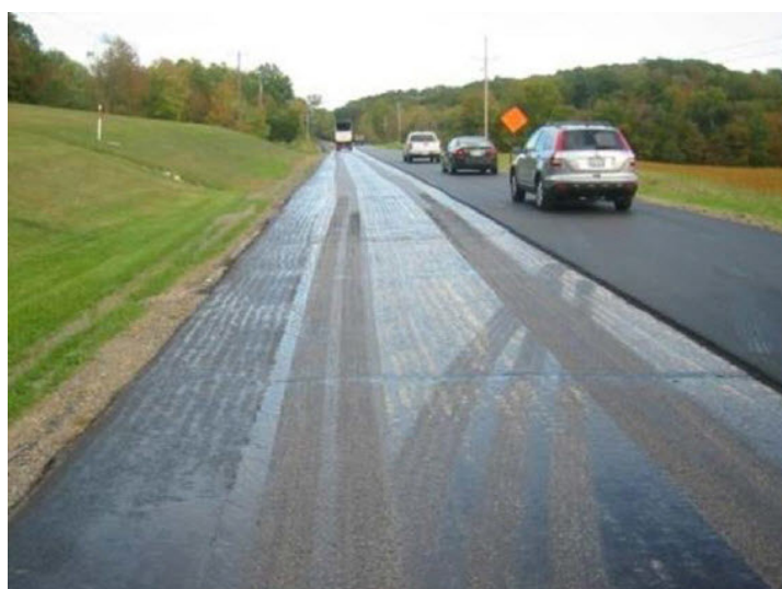
Figura 12. Arrastre riego de liga debido al tránsito de vehículos sobre la emulsión.
