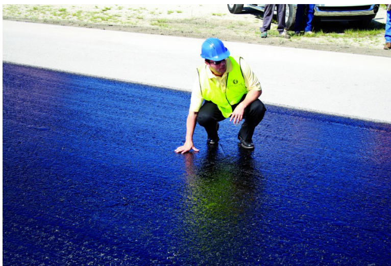
Figura 13. Trackless tack coat, tiempo de curado entre 5 y 10 minutos.
