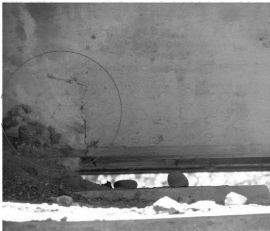
**Figura 7.-** Grietas por concentración de esfuerzos en los apoyos expansivos
