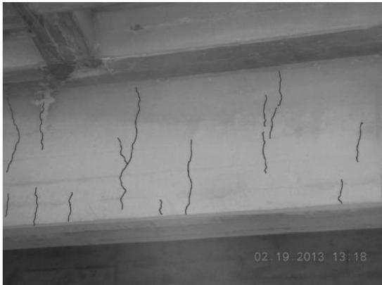
**Figura 6.-** Grietas (resaltadas) por retracción en caras externas de vigas externas.
