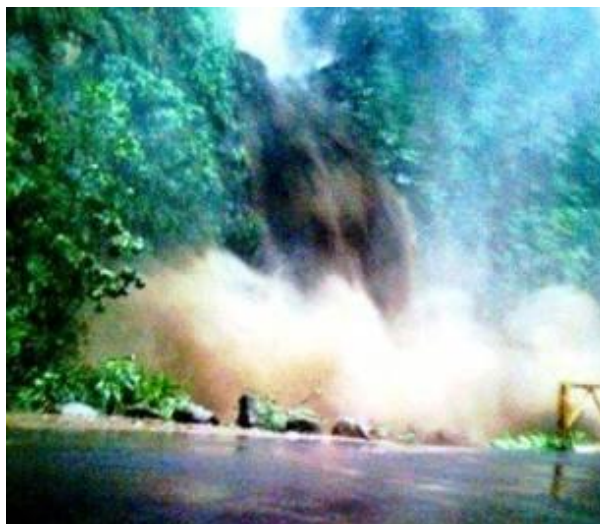
Figura 16.- Se muestra el alud torrencial del 16 de setiembre del 2013 que destruyó el puente Bailey colocado en el 2003 (tomado de crhoy.com , 2013).
