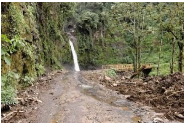
Figura 14.- Se observa el puente Bailey frente a la Catarata de La Paz en buen estado días después del Terremoto de Cinchona (Fotografía del periódico Al Día , 2009).
