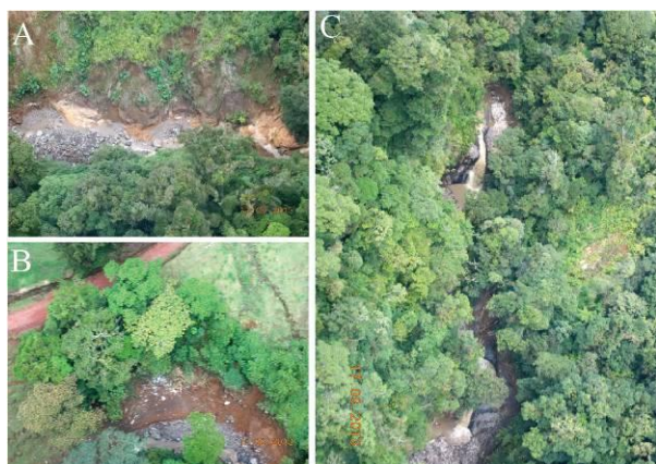
Figura 18.- (A). Vista de cauce del río La Paz Grande aguas arriba del sitio de la Catarata de La Paz. Se observa cómo el cauce está libre de obstáculos importantes y sus taludes aún sin vegetación por los deslizamientos del Terremoto de Cinchona. (B) Se observan escombros, y material suelto que eventualmente podría represar el cauce. (C). Saltos en el cauce libre del río La Paz Grande (Fotografías de LanammeUCR).
