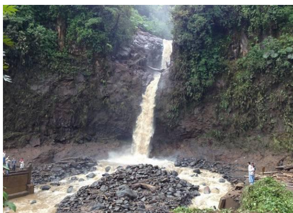
Figura 17.- Sitio donde se encontraba colocado el puente tipo Bailey arrasado. Nótase que la caída de bloques de tamaño métrico redujo la capacidad hidráulica del cauce (tomado de La Nación , 2013).
