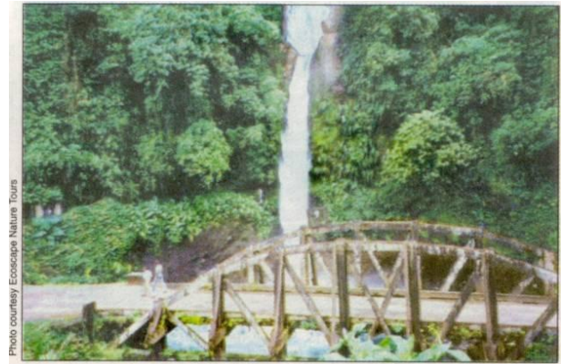
Figura 12.- Puente original de arcos de madera sobre el río La Paz Grande en la RN 126, antes de colapsar (fotografía del periódico The Tico Times , 2003).
