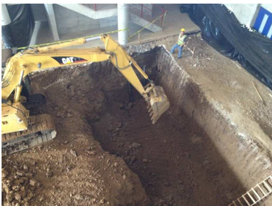
Figura 1.- Excavación de la fosa para la construcción de las pistas
