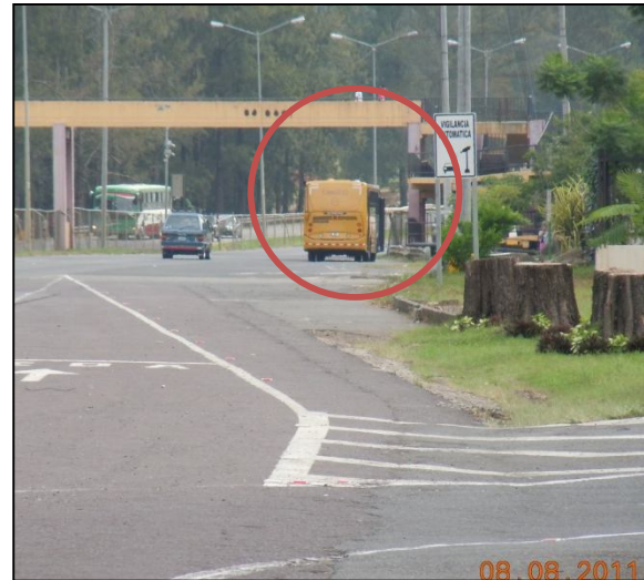
Fotografía 3. Las gradas del puente peatonal reducen la visibilidad en la curva.
