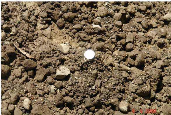
Figura 6 Etapas de la estabilización: caracterización del material, diseño y construcción
