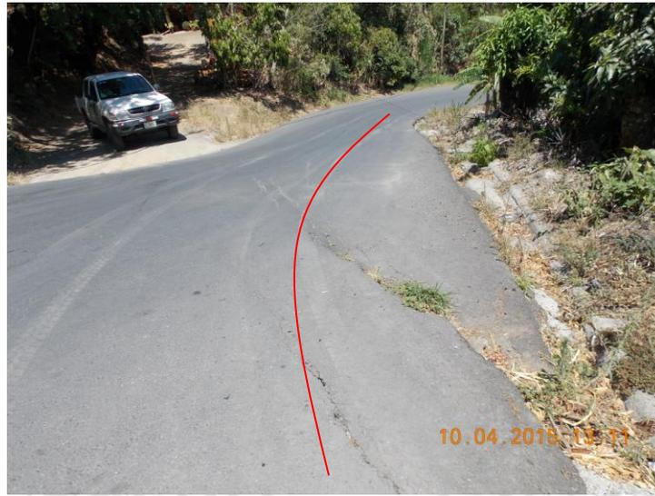
**Figura 50.** Hundimiento tramo 28.
