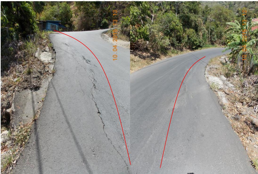
**Figura 49.** Hundimiento en el tramo 28 .
