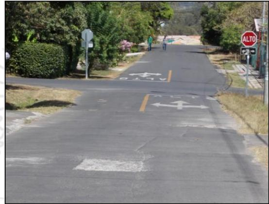
**Figura 26.** Contraste de la condición superficial a ambos lados de la intersección.
