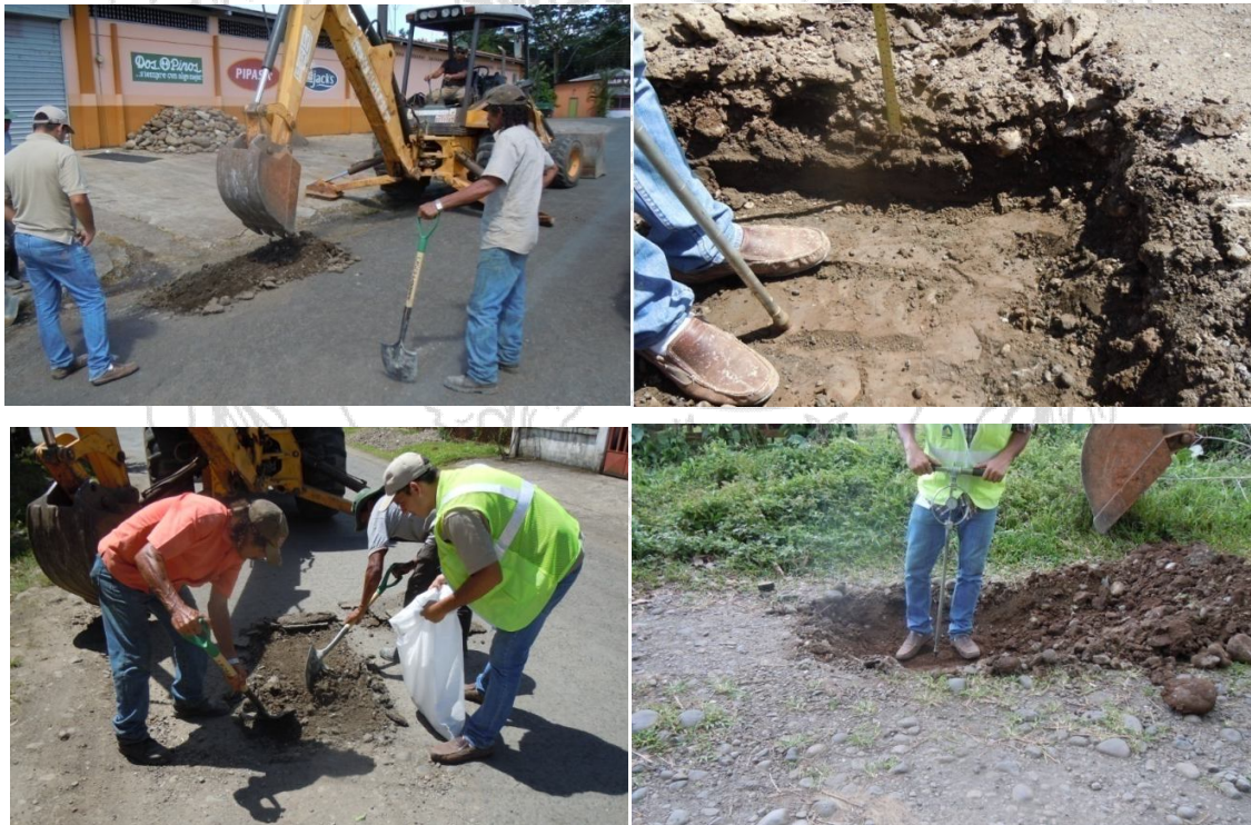
Figura 6. Excavación de sondeos a cielo abierto en diferentes puntos de los caminos de Canalete, Upala.
