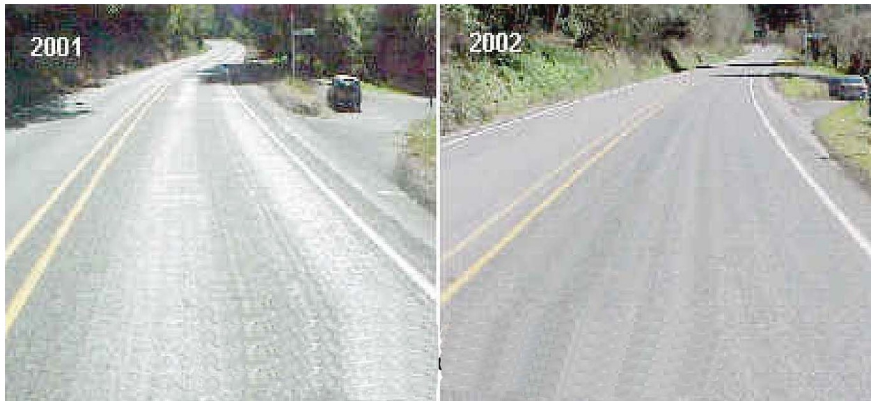
Fotografía 1. Carretera antes y después de un T.S.B.
