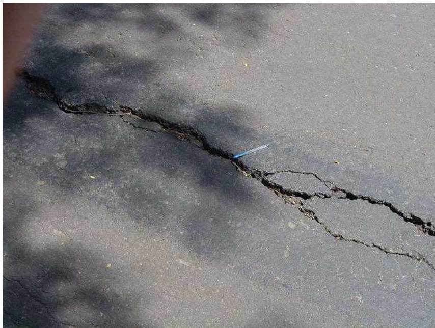
Figura N°2: Grietas longitudinales
