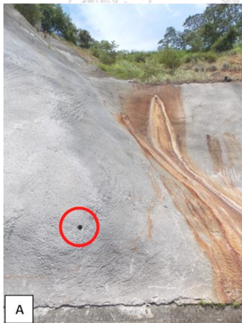
Figura 58. Sitio de extracción del núcleo No.4., km 38+515. A) Vista general del talud y del punto de la extracción. Al lado derecho del sitio de extracción se observan patinas de hierro y sales sobre el concreto. B) Interior de la perforación, se detalla el corte de las varillas que fueron extraídas como parte del núcleo de concreto.
