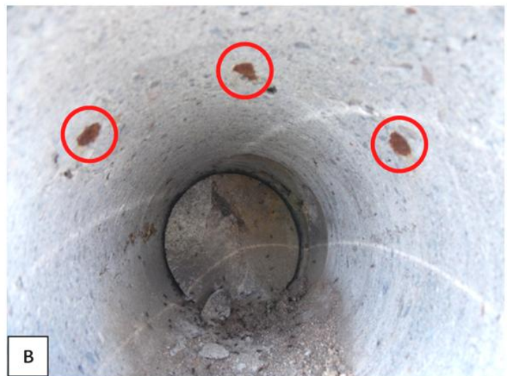
Figura 62. Sitio de extracción del núcleo No.10., km 44+356. A) Vista general del talud y del punto de la extracción. B) Interior de la perforación, se detalla el corte de las varillas que fueron extraídas como parte del núcleo de concreto.
