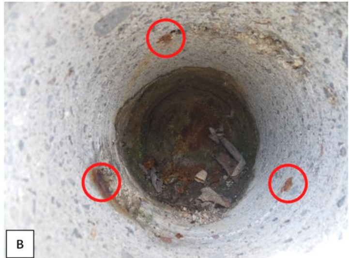
Figura 67. Sitio de extracción del núcleo No.20., km 46+970. A) Vista general del talud y del punto de la extracción. B) Interior de la perforación, se detalla el corte de las varillas que fueron extraídas como parte del núcleo de concreto.
