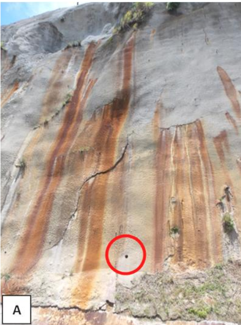
Figura 59. Sitio de extracción del núcleo No.5., km 38+570. A) Vista general del talud y del punto de la extracción. B) Interior de la perforación, se detalla el corte de las varillas que fueron extraídas como parte del núcleo de concreto.
