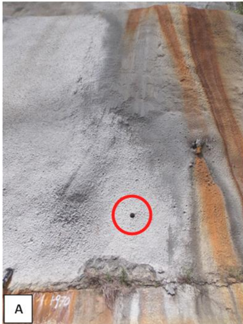
Figura 67. Sitio de extracción del núcleo No.20., km 46+970. A) Vista general del talud y del punto de la extracción. B) Interior de la perforación, se detalla el corte de las varillas que fueron extraídas como parte del núcleo de concreto.
