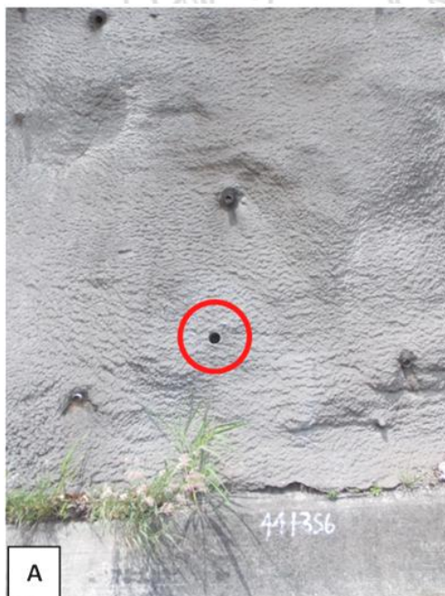
Figura 62. Sitio de extracción del núcleo No.10., km 44+356. A) Vista general del talud y del punto de la extracción. B) Interior de la perforación, se detalla el corte de las varillas que fueron extraídas como parte del núcleo de concreto.
