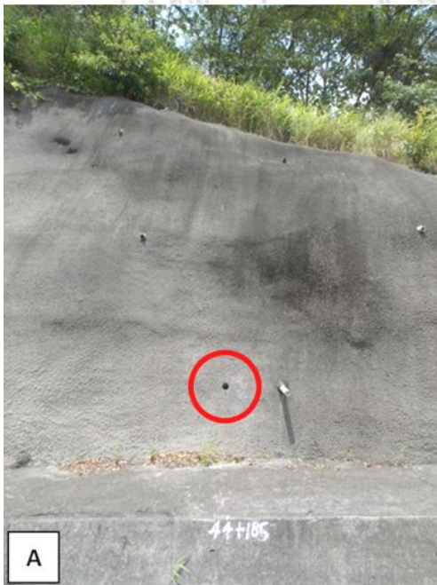
Figura 60. Sitio de extracción del núcleo No.8., km 44+185. A) Vista general del talud y del punto de la extracción. B) Interior de la perforación, se detalla el corte de las varillas que fueron extraídas como parte del núcleo de concreto.
