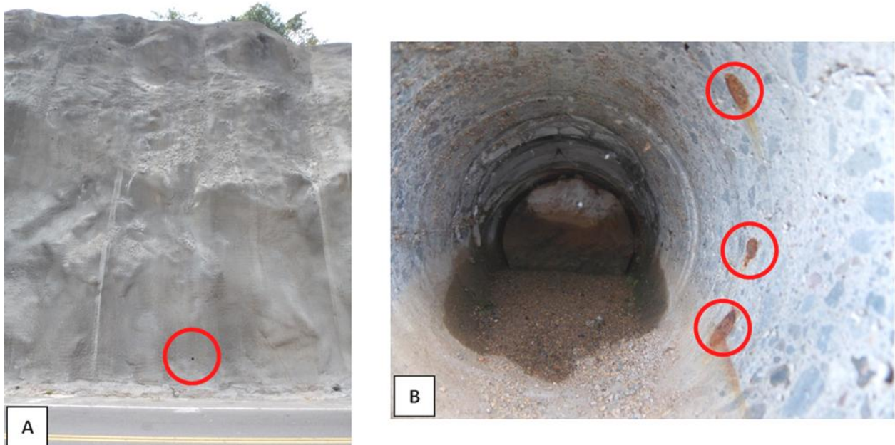
Figura 65. Sitio de extracción del núcleo No.18., km 46+440. A) Vista general del talud y del punto de la extracción. B) Interior de la perforación, se detalla el corte de las varillas que fueron extraídas como parte del núcleo de concreto.
