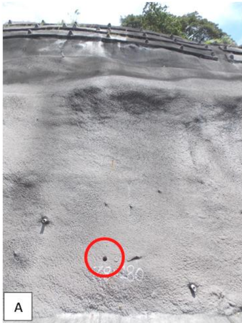
Figura 57. Sitio de extracción del núcleo No.3., km 38+180. A) Vista general del talud y del punto de extracción. B) Interior de la perforación, se detalla el corte en las varillas que fueron extraídas como parte del núcleo de concreto.
