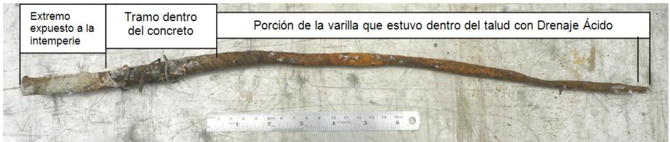
Figura 41. Varilla obtenida del talud en el km 38+600. Es un cabo de varilla #4, de 48,9 cm de longitud. Se observa el deterioro severo del acero en el tramo que estuvo dentro del medio ácido del talud, con pérdida importante de su sección.
