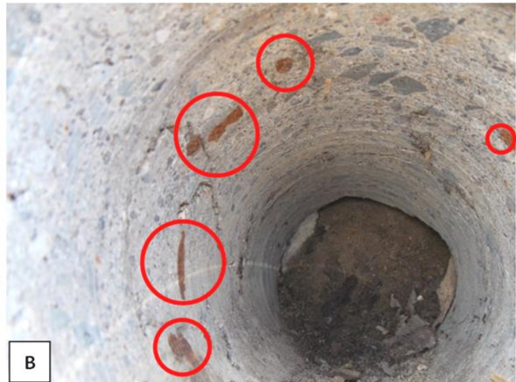
Figura 60. Sitio de extracción del núcleo No.8., km 44+185. A) Vista general del talud y del punto de la extracción. B) Interior de la perforación, se detalla el corte de las varillas que fueron extraídas como parte del núcleo de concreto.
