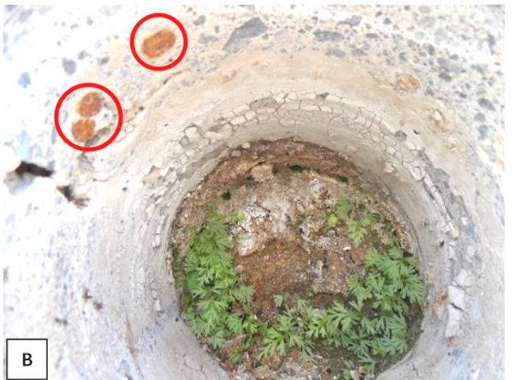
Figura 58. Sitio de extracción del núcleo No.4., km 38+515. A) Vista general del talud y del punto de la extracción. Al lado derecho del sitio de extracción se observan patinas de hierro y sales sobre el concreto. B) Interior de la perforación, se detalla el corte de las varillas que fueron extraídas como parte del núcleo de concreto.
