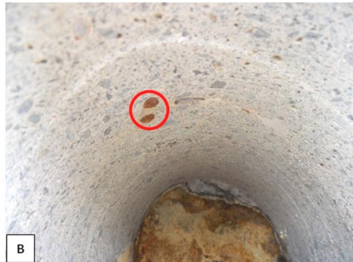
Figura 68. Sitio de extracción del núcleo No.22., km 47+015. A) Vista general del talud y del punto de la extracción. B) Interior de la perforación, se detalla el corte de las varillas que fueron extraídas como parte del núcleo de concreto.
