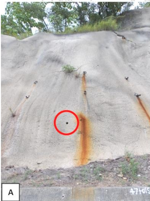
Figura 68. Sitio de extracción del núcleo No.22., km 47+015. A) Vista general del talud y del punto de la extracción. B) Interior de la perforación, se detalla el corte de las varillas que fueron extraídas como parte del núcleo de concreto.
