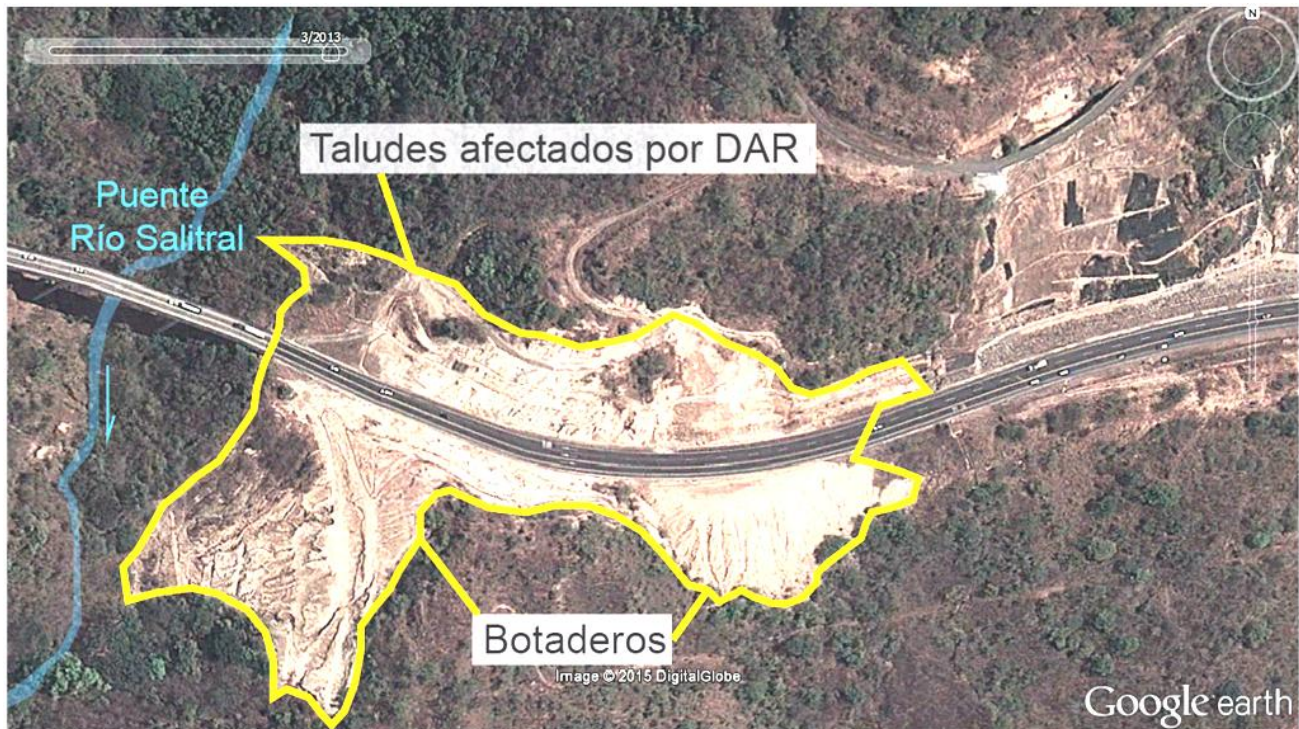
Figura 55. Se muestran los taludes del km 48+000 que presentan DAR, los botaderos y el puente sobre el río Salitral.
