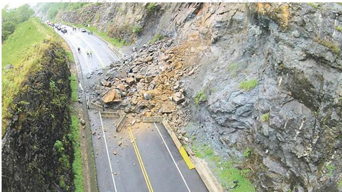
Figura 53. Deslizamiento tipo caída de bloques en km 45+600, generado por las primeras lluvias del 2015. Imagen tomada de Diario Extra, 4 de junio del 2015.
