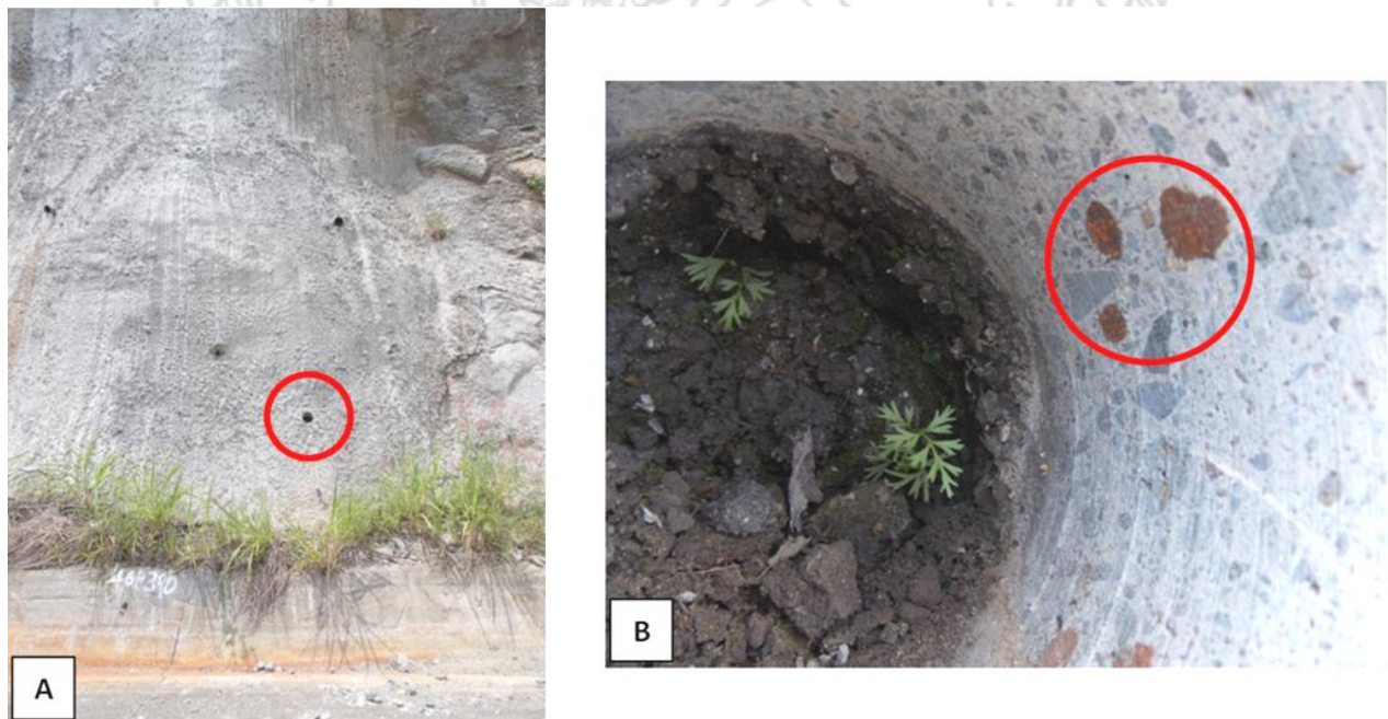
Figura 64. Sitio de extracción del núcleo No.16., km 46+390. A) Vista general del talud y del punto de la extracción. B) Interior de la perforación, se detalla el corte de las varillas que fueron extraídas como parte del núcleo de concreto.
