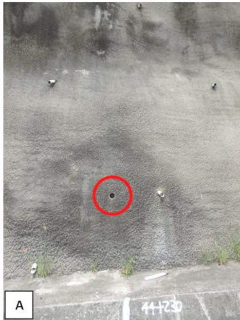
Figura 61. Sitio de extracción del núcleo No.9., km 44+230. A) Vista general del talud y del punto de la extracción. B) Interior de la perforación, se detalla el corte de las varillas que fueron extraídas como parte del núcleo de concreto.
