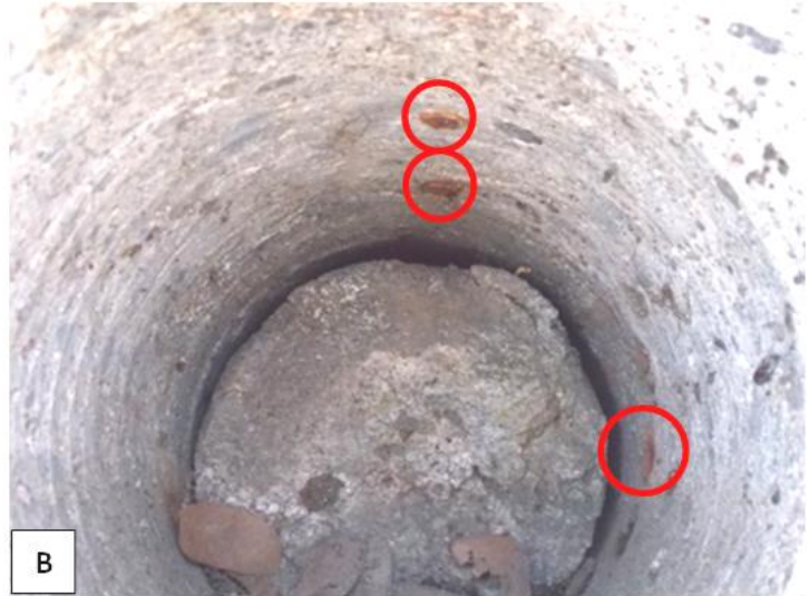
Figura 57. Sitio de extracción del núcleo No.3., km 38+180. A) Vista general del talud y del punto de extracción. B) Interior de la perforación, se detalla el corte en las varillas que fueron extraídas como parte del núcleo de concreto.
