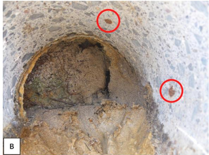
Figura 59. Sitio de extracción del núcleo No.5., km 38+570. A) Vista general del talud y del punto de la extracción. B) Interior de la perforación, se detalla el corte de las varillas que fueron extraídas como parte del núcleo de concreto.
