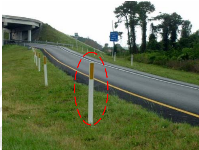
Figura 4. Señalización con delineadores.
