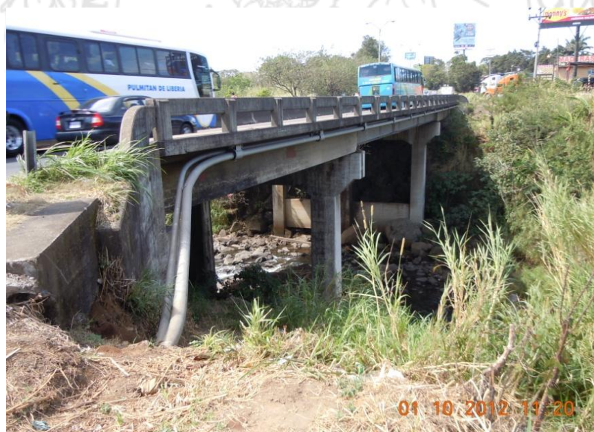
Figura 3: Vista lateral del puente
