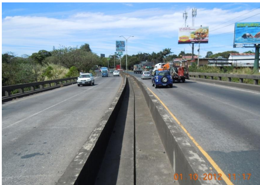
Figura 2: Vista a lo largo de la línea de centro del puente
