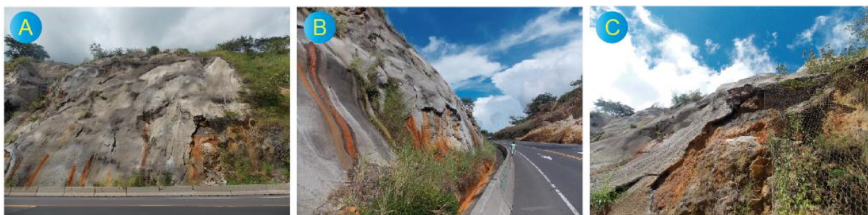
Figura 15. A) Concreto lanzado con patinas de óxidos de hierro en la parte inferior. B.) En la parte central se observa la cuneta con acumulación de óxidos de hierro. C) Colapso de concreto lanzado que deja expuesto el acero de las mallas electro-soldadas.
