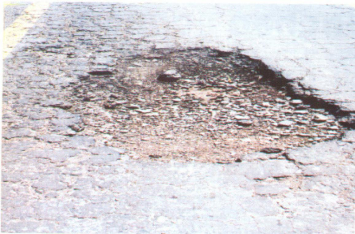
Figura 1: Deterioro en carretera por mala calidad de la mezcla. Este defecto pudo evitarse con la revisión de procesos que ejecuta la Auditoría Técnica de Proyectos.
