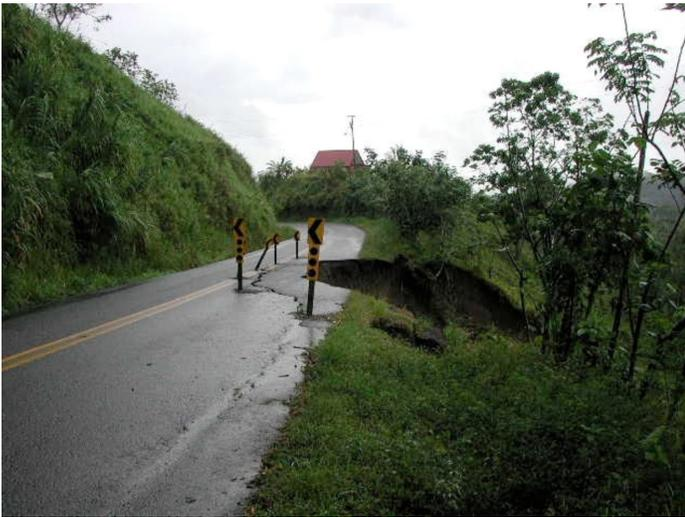
Figura 4. Tercera etapa en la falla de un terraplén (relleno) de una carretera de montaña: pérdida de un carril en la Ruta Nacional N°. 10, 2004. Nótese la escorrentía sobre el pavimento en el borde izquierdo de la vía provocada por la sedimentación de la cuneta. Fuente: Umaña Rodríguez, 2003.
