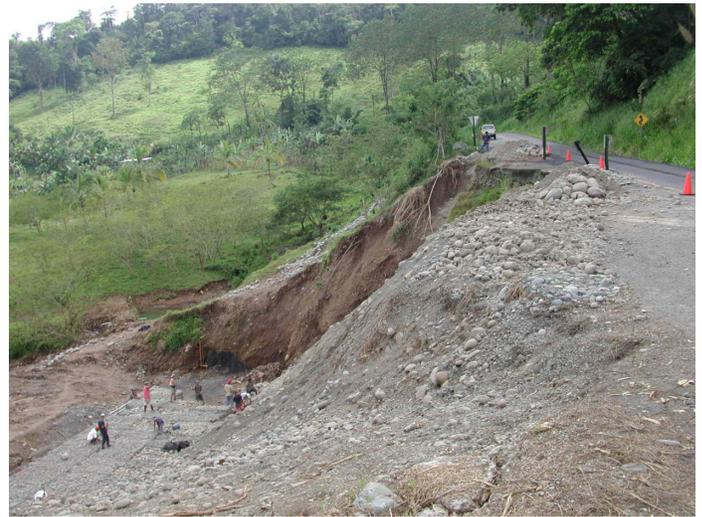
Figura 5. Reparación de la falla de un terraplén de montaña en la Ruta Nacional N°. 10, 2004. Fuente: Archivo de LanammeUCR.
