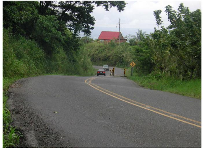
Figura 3. Tercera etapa en la falla de un terraplén (relleno) de una carretera de montaña: hundimientos adicionales y pérdida de un carril en la Ruta Nacional N°. 10, 2004. Fuente: Umaña Rodríguez, 2003.
