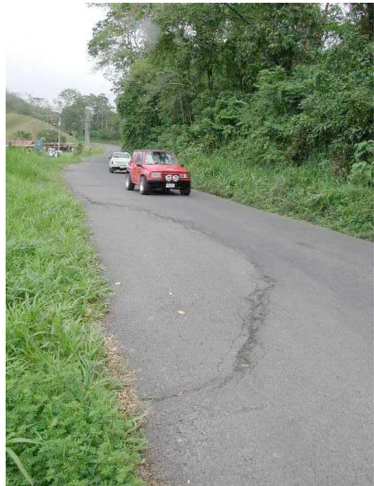
Figura 1. Primera etapa en la falla de un terraplén (relleno) de una carretera de montaña: aparición de grietas con forma de media luna en el pavimento de la Ruta Nacional N° 10, 2003. Nótese la inexistencia de drenajes (cunetas) o su falta de mantenimiento a la derecha de la fotografía. Fuente: Umaña Rodríguez, 2003.
