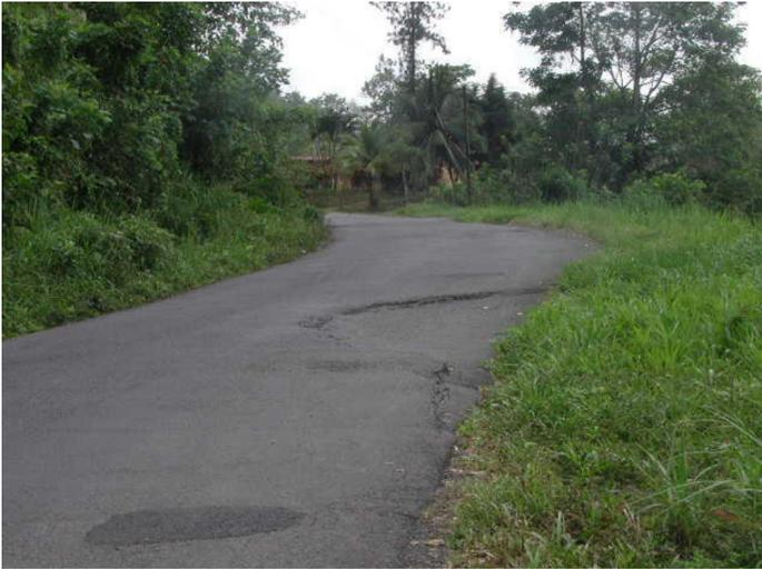
Figura 2. Segunda etapa en la falla de un terraplén (relleno) de una carretera de montaña: hundimiento del pavimento en sectores inestables en la Ruta Nacional N°. 10, 2003. Fuente: Umaña Rodríguez, 2003.
