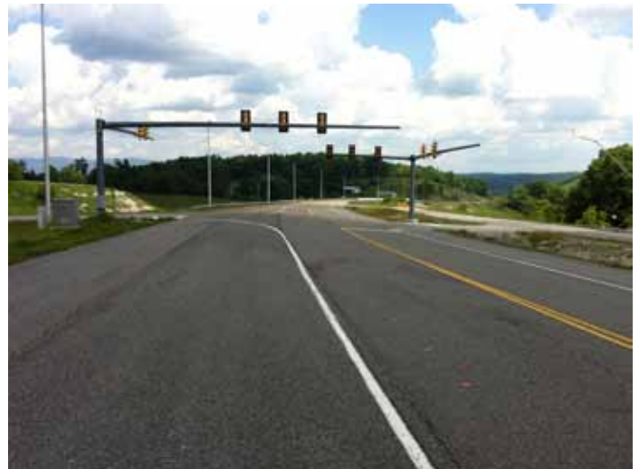
Fig. 8. Intersección señalizada e instrumentada
