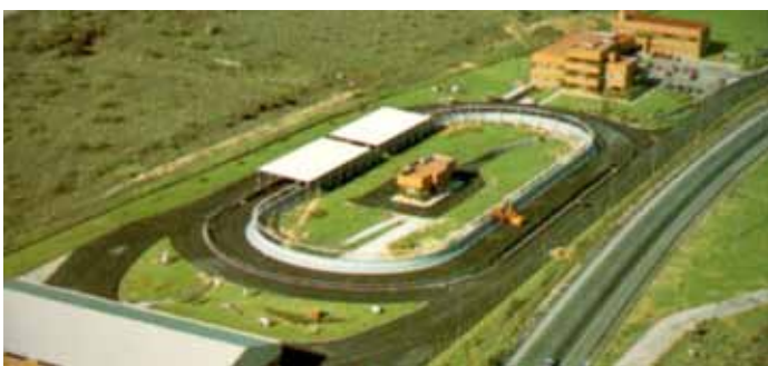
Figura 2. Pista de ensayo de firmes, CEDEX, España. 8
