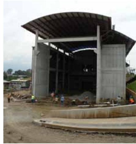
Imagen 7. PaveLab en construcción, Abril de 2012.
