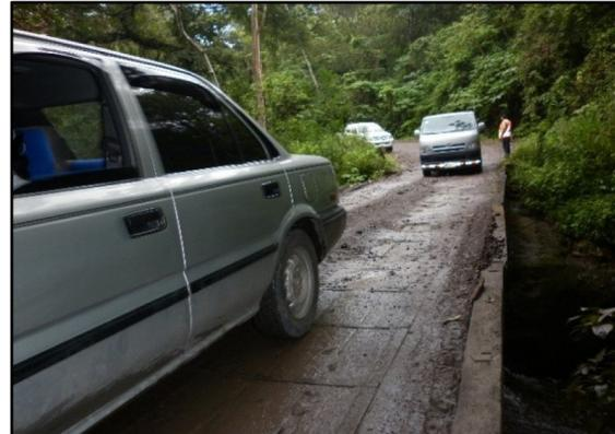
Figura 12. Ausencia de barandas en puentes de redes viales cantonales
