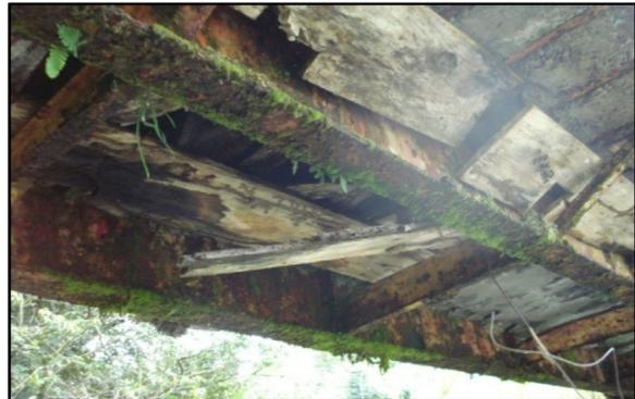
Figura 15. Construcción de puentes con materiales no adecuados
