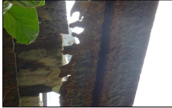
Figura 9. Oxidación de vigas principales
