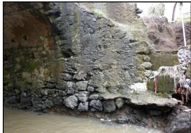
Figura 8. Socavación identificada en puentes municipales
