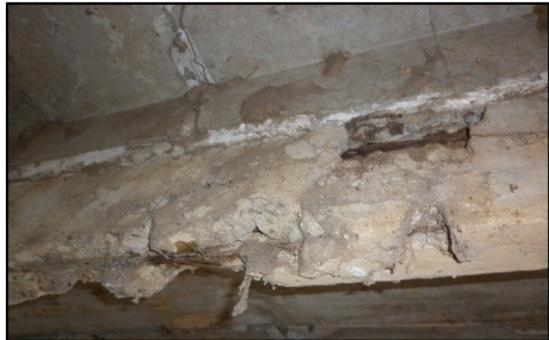
Figura 11. Fallas en vigas principales de acero y concreto
