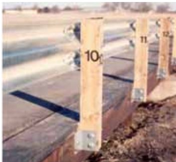
Figura 4. Ejemplo de una baranda tipo TL-1 Fuente: (3)
