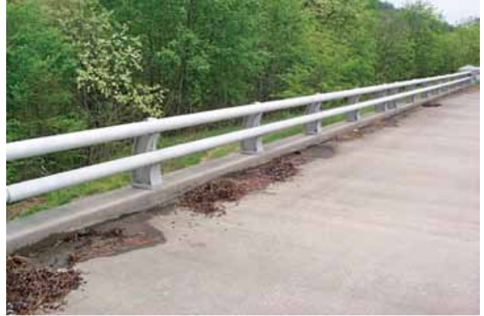
Figura 5. Ejemplo de una baranda tipo TL-2 (Construida de Aluminio) Fuente: (3)
