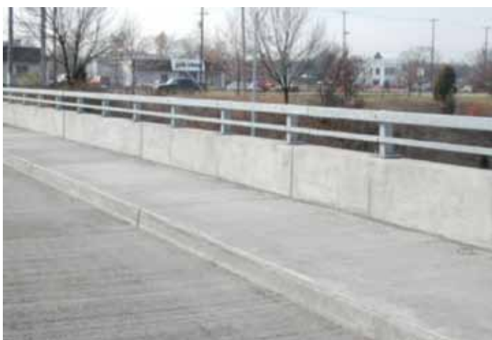
Figura 7. Ejemplo de una baranda tipo TL-4 Fuente: (3)
