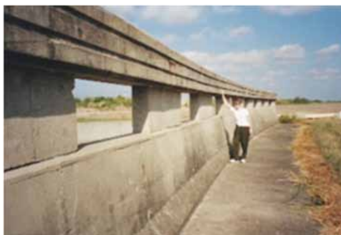
Figura 9. Ejemplo de una baranda tipo TL-6 Fuente: (3)
