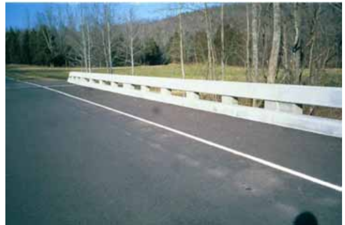
Figura 6. Ejemplo de una baranda tipo TL-3 Fuente: (3)
