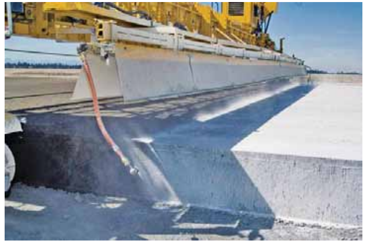
Figura 3. Aplicación de compuesto de curado. Fuente: Concrete Construction
