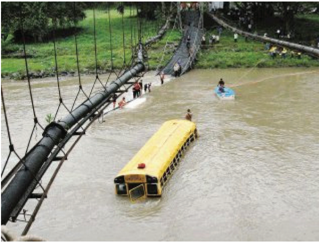
Figura 1. Colapso del puente colgante sobre el Río Grande de Tárcoles - Ruta Nacional 137
