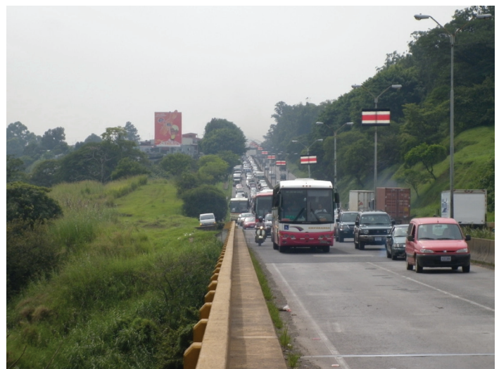
Figura 2. Daño en la junta de expansión. Puente sobre el Río Virilla – Ruta Nacional 1
