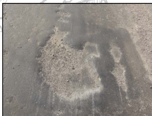
Fotografías 3 y Fotografías 4. Deterioro en la superficie de la base estabilizada. Estacionamiento 12+250 Fecha 25/03/2014
