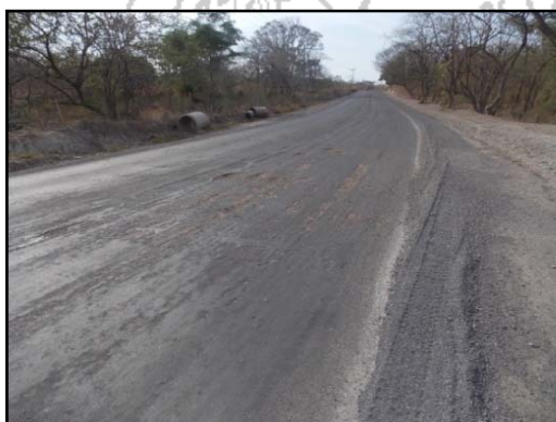
Fotografías 1 y Fotografías 2. Deterioro en la superficie de la base estabilizada. Estacionamiento 12+011 Fecha 25/03/2014
