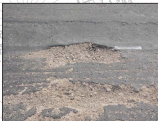
Fotografías 1 y Fotografías 2. Deterioro en la superficie de la base estabilizada. Estacionamiento 12+011 Fecha 25/03/2014
