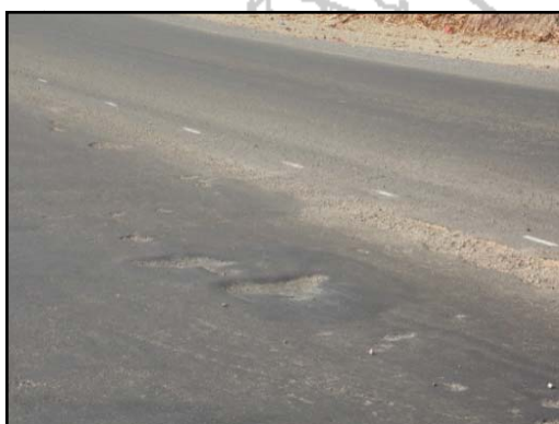
Fotografías 3 y Fotografías 4. Deterioro en la superficie de la base estabilizada. Estacionamiento 12+250 Fecha 25/03/2014
