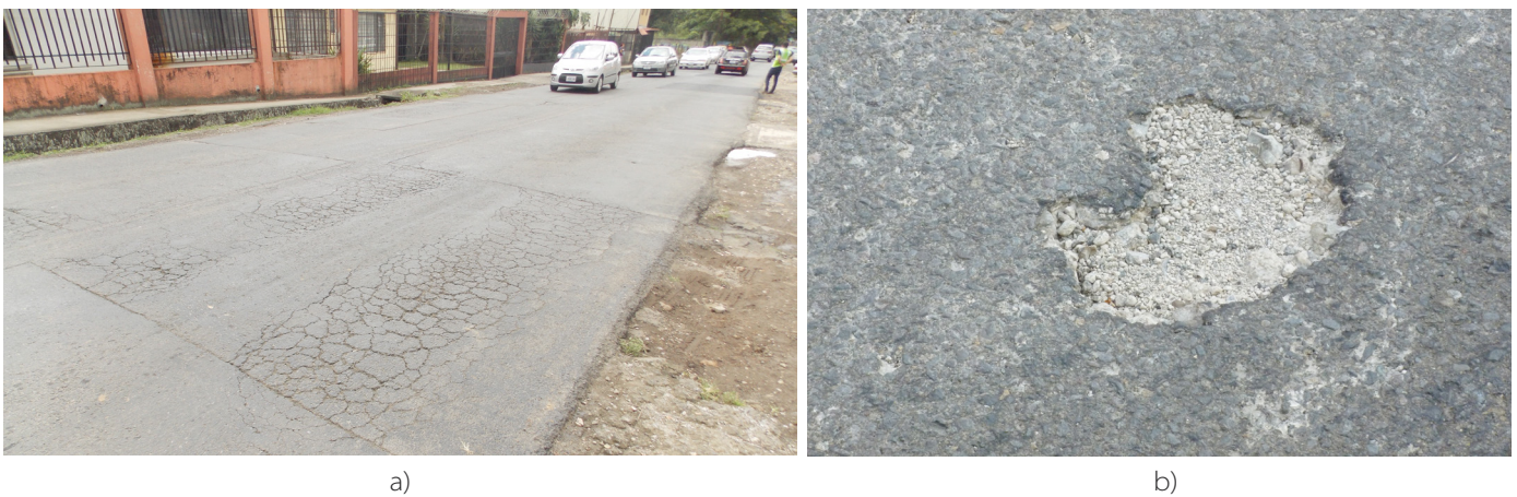
Figura 2. Fallas típicas del pavimento intensificadas por la oxidación del ligante asfáltico: a) grietas en el pavimento producto de asfalto frágil; b) desprendimiento del asfalto de la superficie del agregado (desnudamiento).
