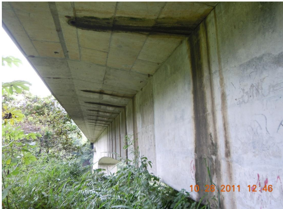
Figura 10. Drenajes de la superestructura sin tubo de extensión que evite el contacto del agua con las paredes de la viga cajón.
