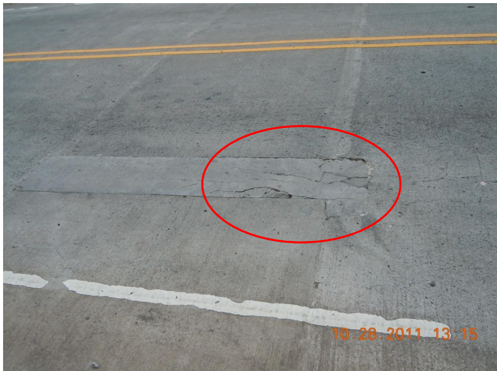
Figura 6. Descascaramiento del concreto en zonas reparadas de la losa.
