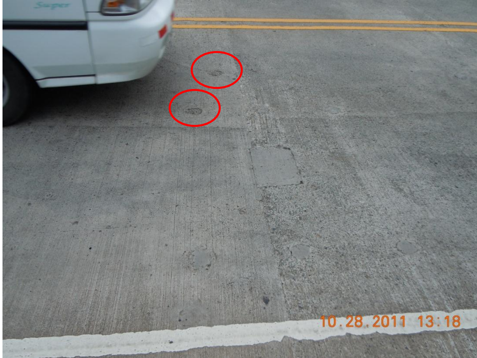
Figura 7. Desprendimiento del concreto en zonas donde se extrajeron núcleos de concreto de la losa.
