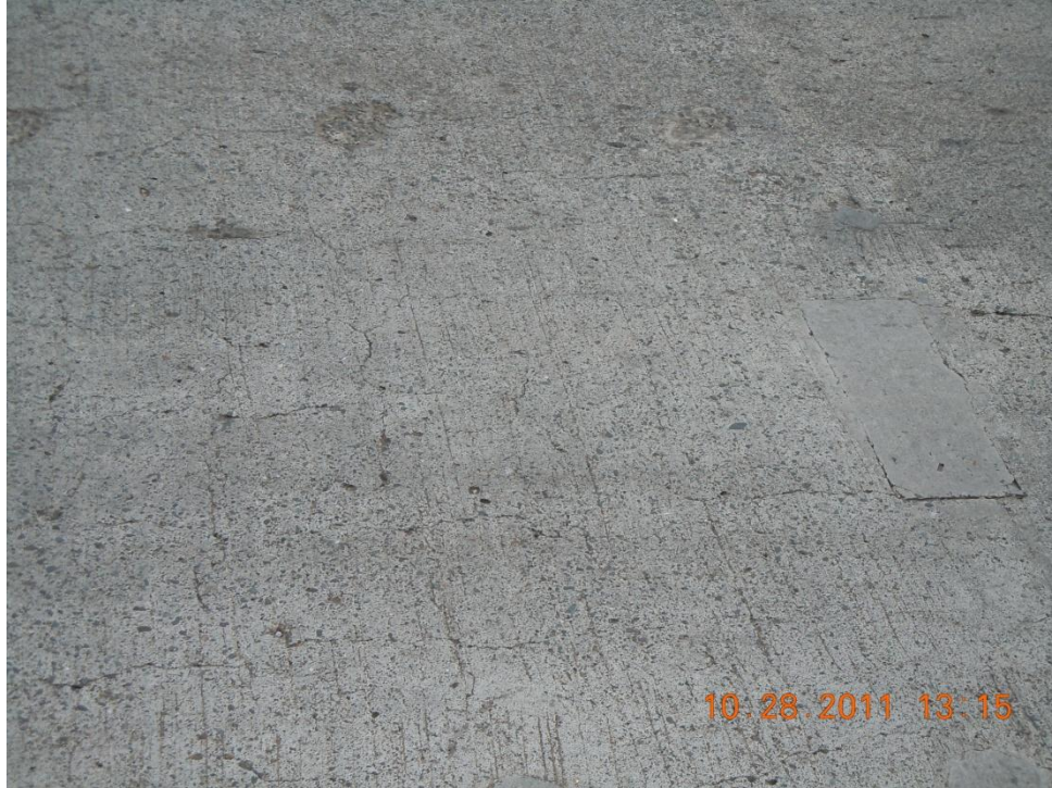
Figura 5. Agrietamiento en dos direcciones en la losa de rodadura.
