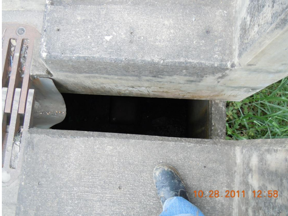
Figura 11. Placa de aluminio faltante del sistema de desagüe bajo la junta de expansión del acceso este que ocasiona que la viga cabezal de los bastiones y los apoyos se encuentren en contacto continuo con la humedad y se produzca acumulación de sedimento.
