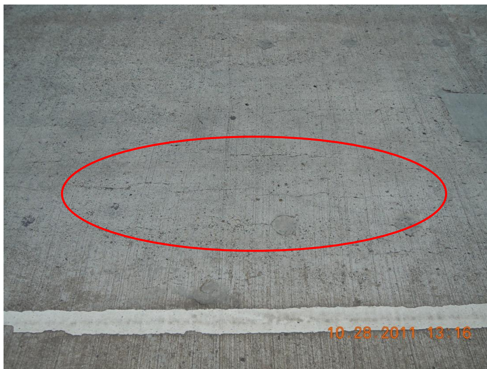
Figura 4. Agrietamiento en una dirección en la losa de rodadura.
