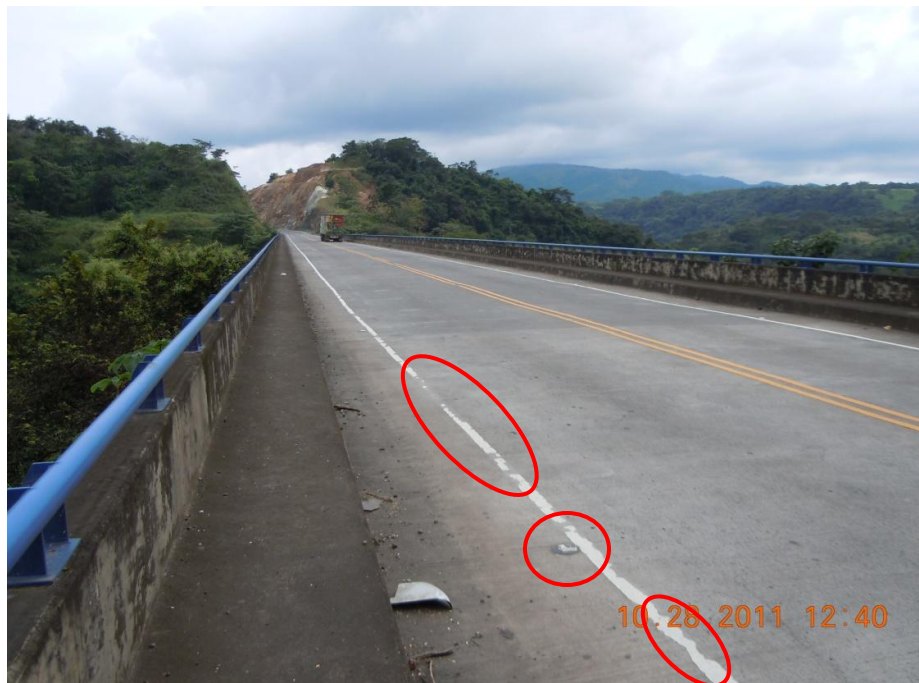
Figura 12. Línea de borde en regular estado y captaluces faltantes o deteriorados.
