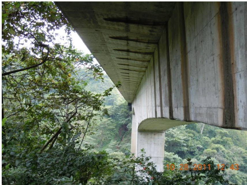
Figura 3. Vista lateral del puente
