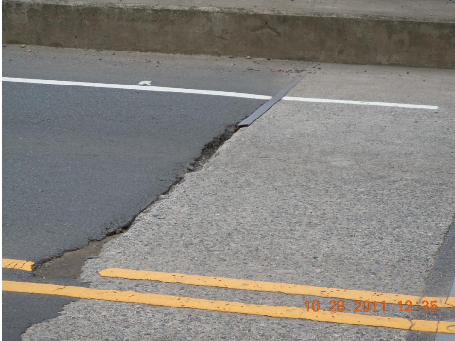
Figura 9. Desprendimiento de angular de protección en el extremo este de la losa de aproximación del puente.
