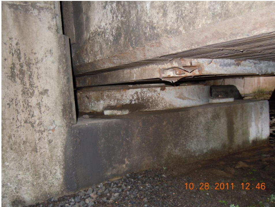
Figura 8. Oxidación de los elementos metálicos de los apoyos sobre los bastiones.
