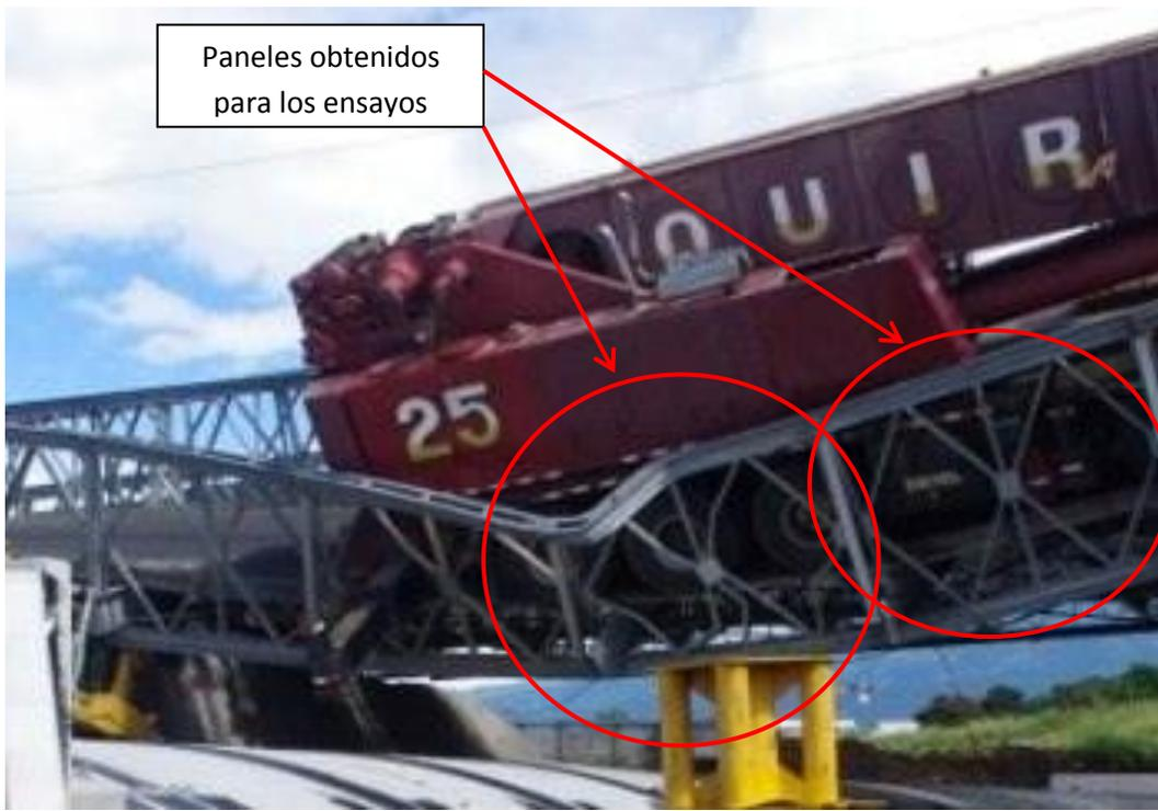
**Figura 2.** Puente modular tipo Bailey colapsado en la autopista general Cañas
