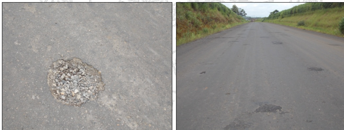
Figura 4. (a) y (b) Deterioro en la base granular. Estacionamiento 20+950 Fecha: 20 de agosto de 2015.
