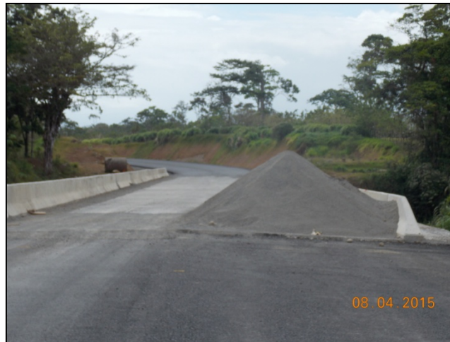
Figura 19. Puente sobre el río Toro. Estación 17+300. Fecha: 08 de marzo de 2015.
