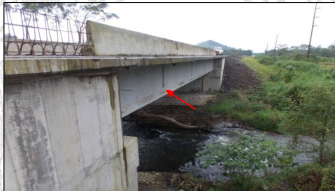
Figura 7. (a) Descarga de agua sobre la pila del puente sobre el Río Toro. Fecha: 10 de diciembre 2014.
