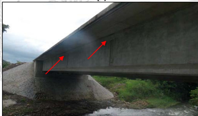
Figura 8. Tubos de desagüe inadecuados. Puente sobre Quebrada Pericos.(a) Fecha: 10 de diciembre 2014 y (b) Fecha: 16 de julio de 2015
