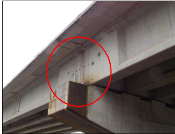
Figura 7. (a) Descarga de agua sobre la pila del puente sobre el Río Toro. Fecha: 10 de diciembre 2014.
