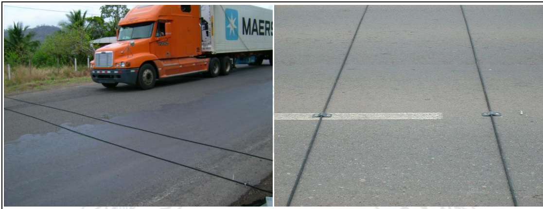
Figura 4. Cables y contadores automáticos en sitio.
