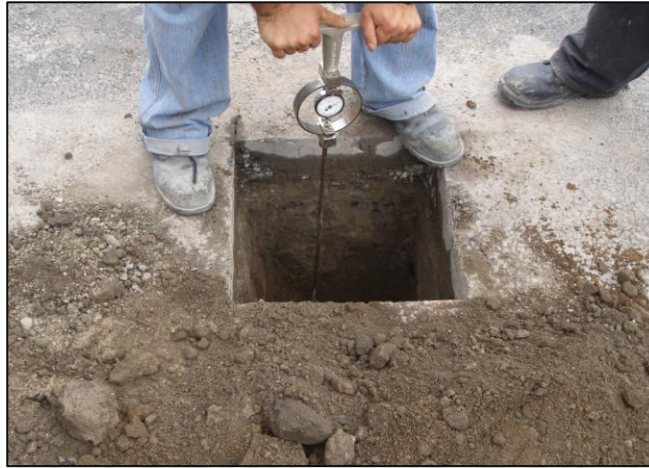
Figura 31. Prueba de CBR en sitio.
