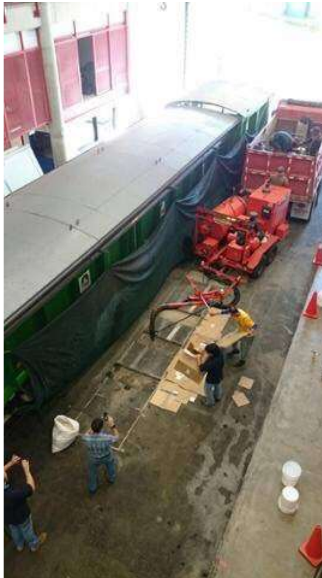
Figura 13: Construcción de baches en pista de prueba del PaveLab
