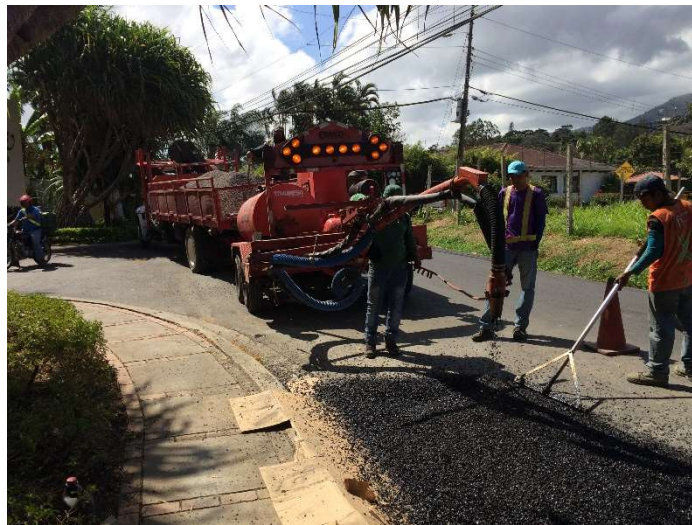
Figura 1: Ejemplo del tipo unidad remolcada. Fuente: Trabesa S.A.
