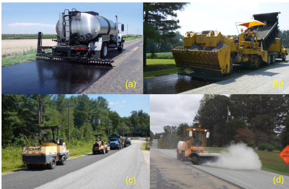
Figura 3. Proceso de construcción de un tratamiento superficial: a) distribución de emulsión, b) distribución de agregado, c) barrido y d) compactación.
