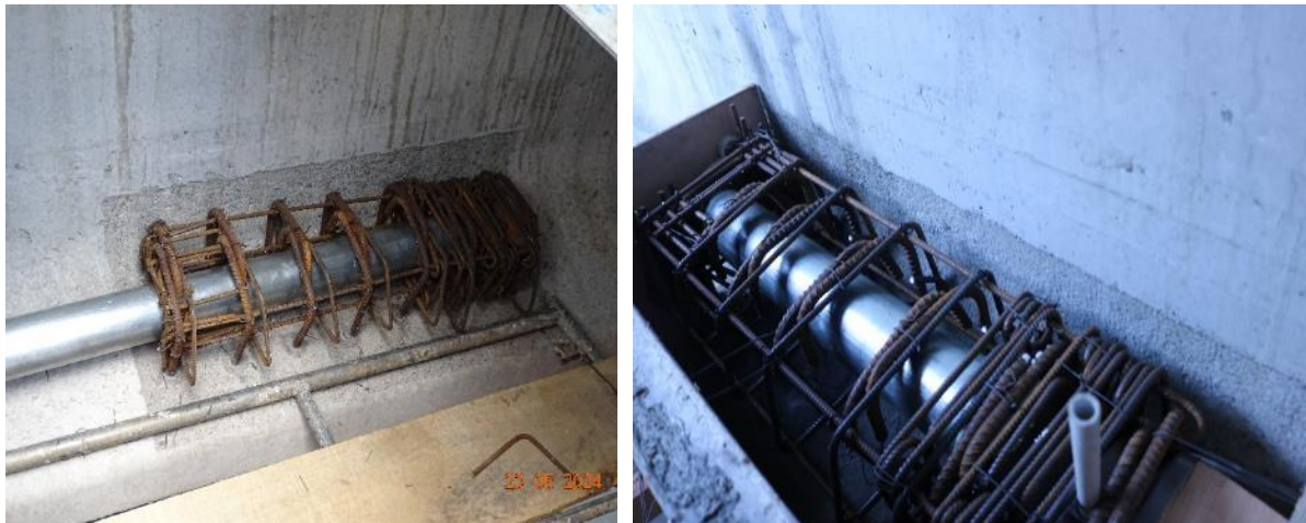
Figura 4. Encofrado y distribución de acero de bloque de concreto que forma parte de las reparaciones de las vigas del vano 4 del paso superior del proyecto. Fecha: 23 de mayo y 30 de mayo de 2024.
