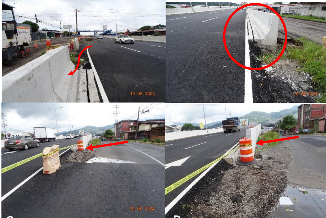
Figura 48. Terminales de barrera expuestos al tránsito vehicular en el paso elevado. Fecha: 19 de agosto de 2024
