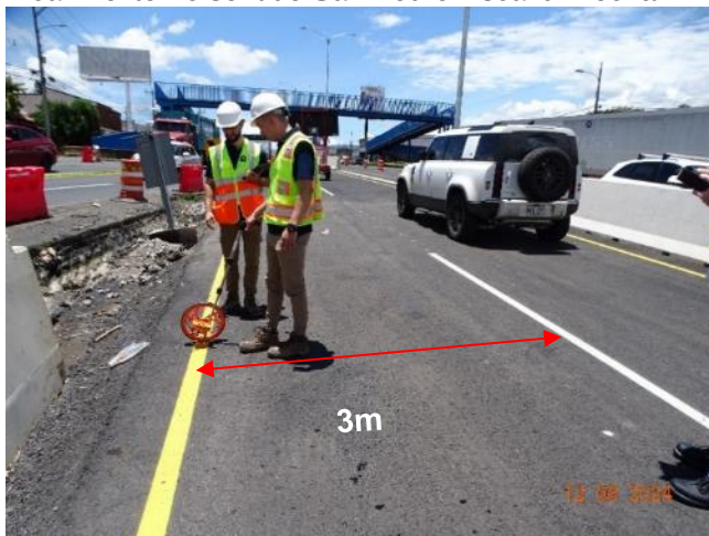
Figura 40. Ancho de 3 m carril externo sentido San Pedro-Escazú. Fecha 12 de agosto de 2024
