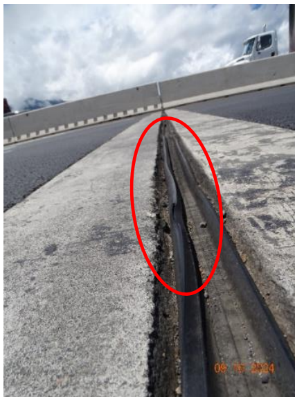
Figura 21 Abertura y daño del material elastomérico de la junta de expansión Bastión 1 sentido San Pedro-Pavas. Fecha: 09 de octubre de 2024.
