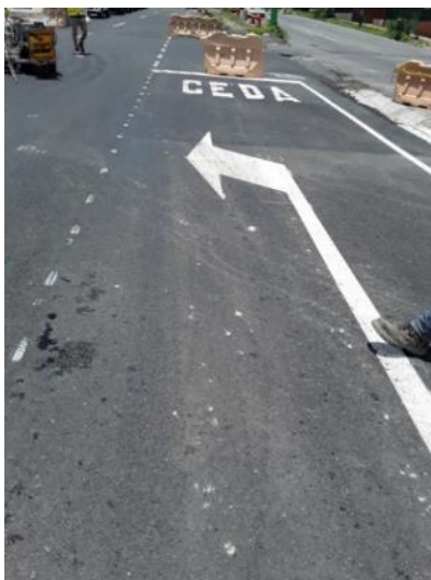
Figura 41. Longitud transición del CEDA aproximadamente 50m. Fecha:12 de agosto de 2024
