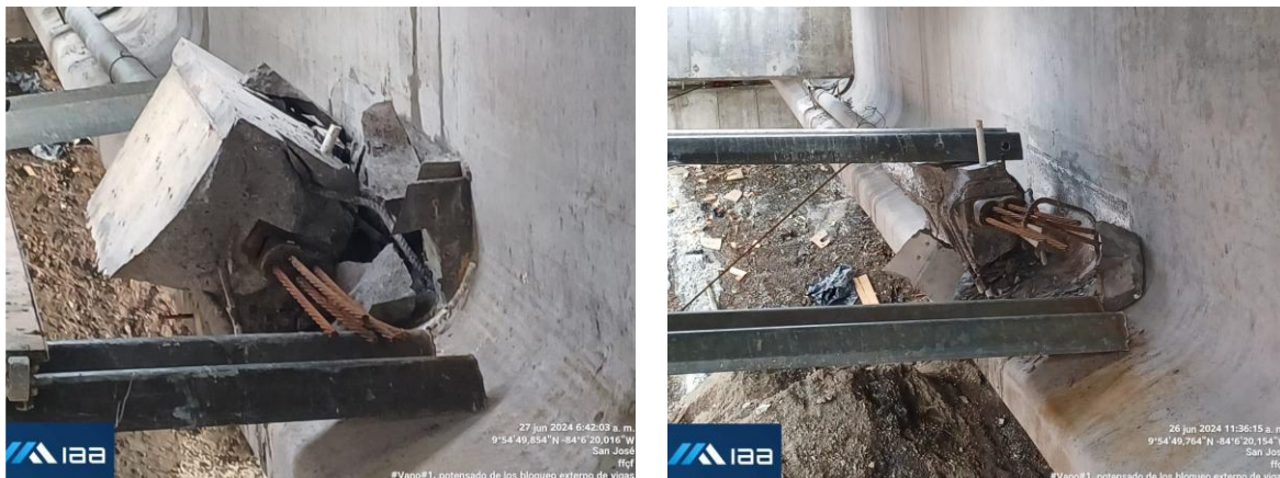
Figura 7. Fallas bloques del sistema de postensión exterior en vigas vano 1. Fechas: 26 y 27 de abril de 2024. Fuente: IIML HATILLO 4, 2024.
