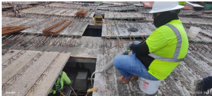
Figura 8 Proceso inyección del bloque de concreto considerado en el reforzamiento de las vigas. Fechas: 27 de junio de 2024.
