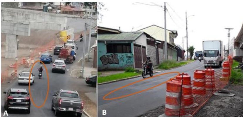
Figura 39. Borrado inadecuado de la demarcación vial existente. Fotografías tomadas el 24 de abril de 2024 (A) y el 17 de julio de 2024 (B).
