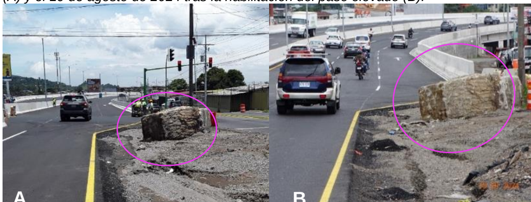
Figura 42 Obstáculos de concreto al margen de las vías de tránsito. Fechas: 12 de agosto de 2024 (A) y el 19 de agosto de 2024 tras la habilitación del paso elevado (B).
