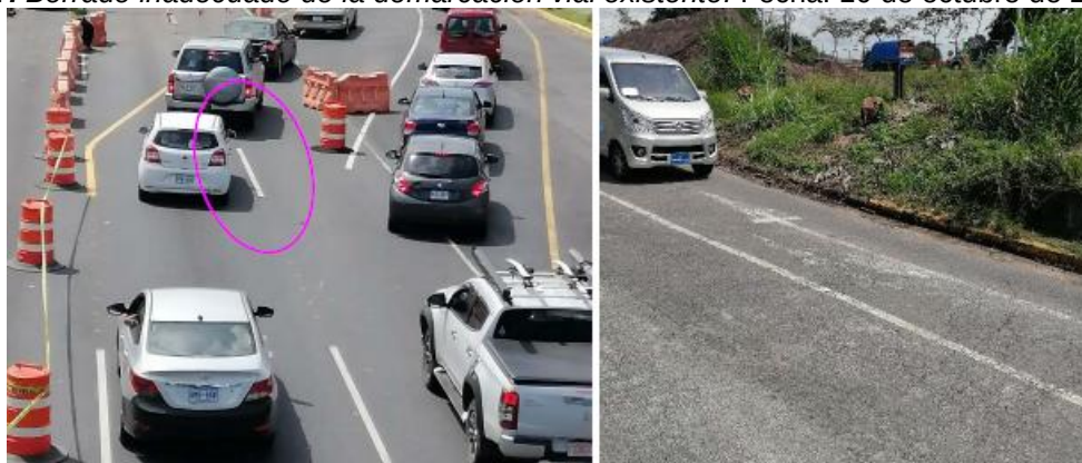
Figura 38. Borrado inadecuado de la demarcación vial existente. Fecha: 22 de noviembre de 2023.
