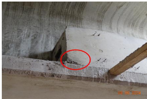
Figura 5. Burbujas de aire marcadas en acabado y nidos de piedra bloques viga vano 4. Fecha: 06 de junio de 2024
