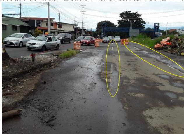
Figura 38. Borrado inadecuado de la demarcación vial existente. Fecha: 22 de noviembre de 2023.
