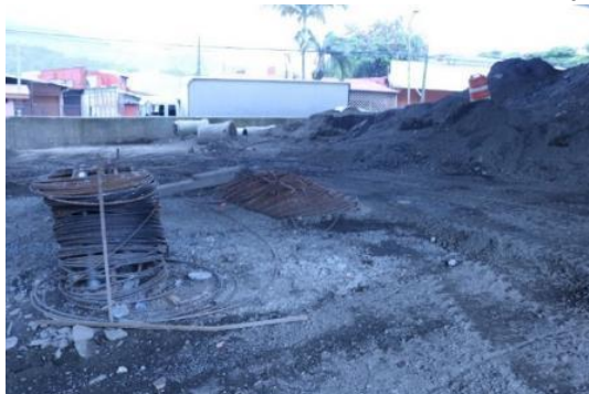
Figura 25. Condición de rollos torones observada en sitio. Fecha: 17 de julio de 2024
