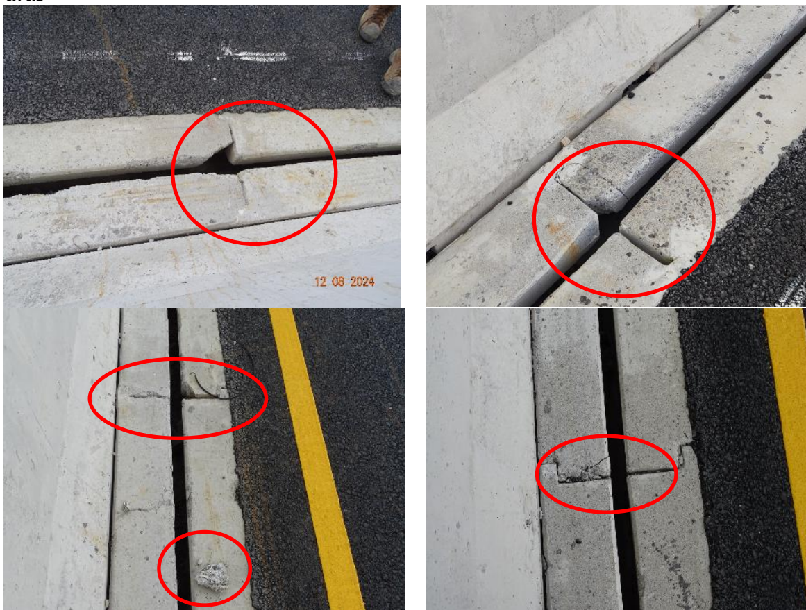
Figura 18 Daños y fractura de concreto en slot drain ubicado en carril interno en sentido San Pedro-Pavas
