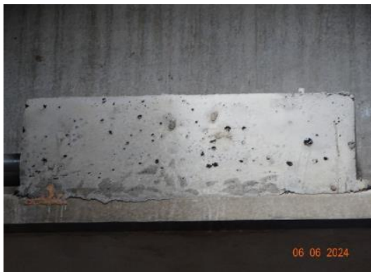
Figura 5. Burbujas de aire marcadas en acabado y nidos de piedra bloques viga vano 4. Fecha: 06 de junio de 2024
