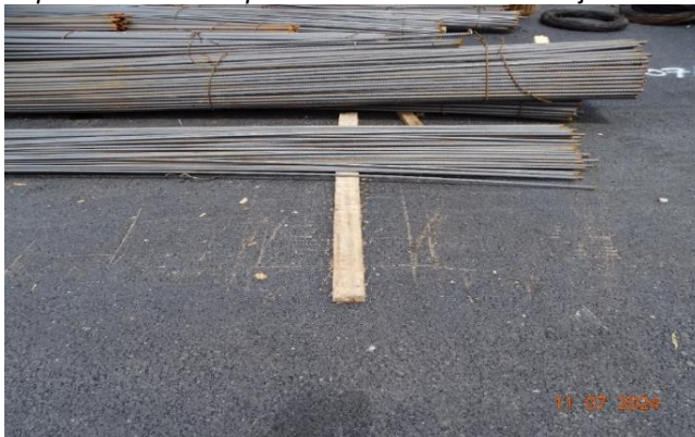
Figura 16. Rasgado de superficial de la capa asfáltica. Fecha 11 de julio de 2024.
