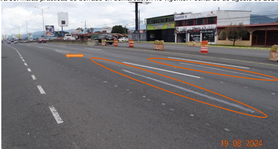
Figura 50. Malas prácticas de borrado en demarcación no vigente. Fecha: 19 de agosto de 2024
