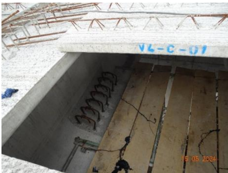
Figura 3 Colocación de pines como parte del proceso constructivo del sistema de postensado por implementar como medida mitigatoria al problema de deflexiones. Fecha: 15 de mayo de 2024.
