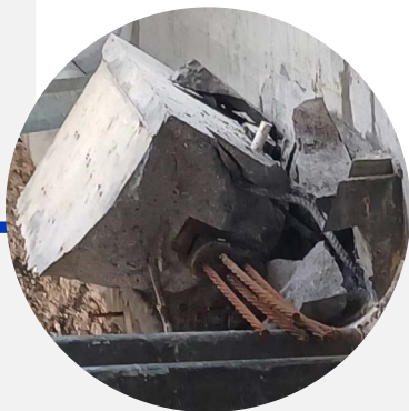
Proceso de reparación de las vigas del paso superior: Fallas bloques del sistema de postensión exterior en vigas vano 1
