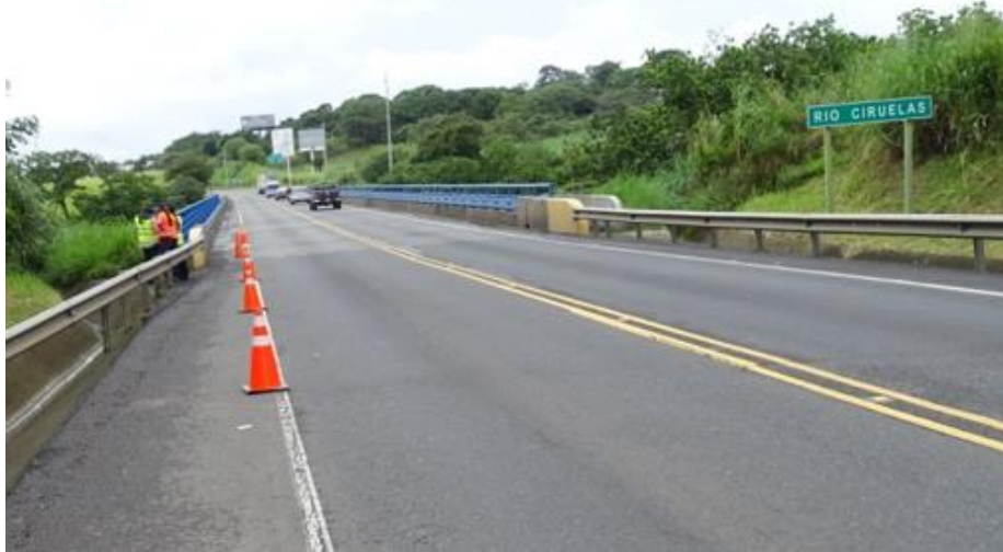
Figura 4.2. Vista a lo largo de la línea de centro del puente hacia Orotina.
