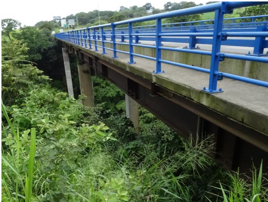
Figura 4.3. Vista lateral del costado aguas abajo del puente.
