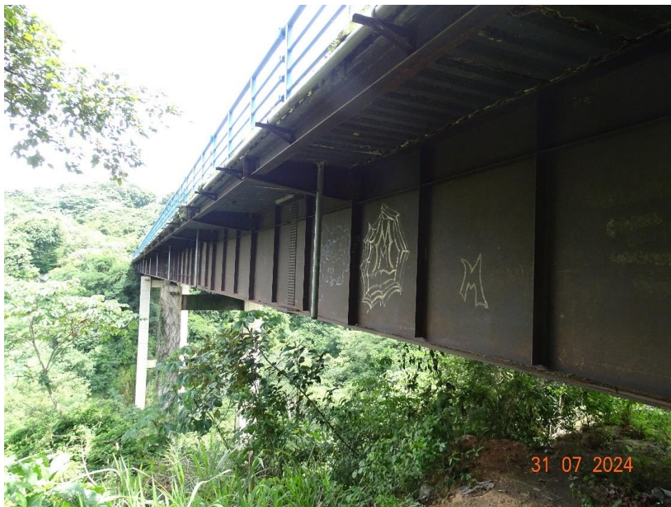
Figura 4.3. Vista lateral del costado sur del puente
