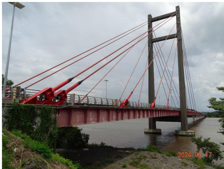
Figura 4.1. Vista lateral del costado aguas abajo del puente
