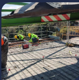
Construcción de rozas para reforzamiento del puente Marzo 2024
