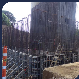
Trabajos en pila 3 Agosto 2023
