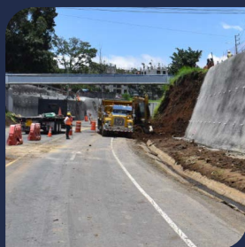
Colocación de puente en calle Rojas Agosto 2024
