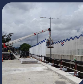
Colocación de barrera de seguridad Agosto 2024
