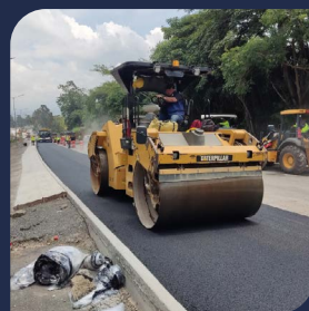
Colocación de carpeta asfáltica en Rampa 1 Septiembre 2024
