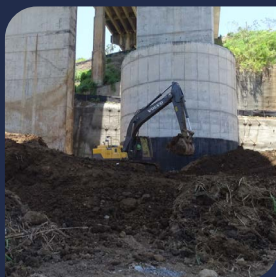
Movimientos de tierra en pila 2 Mayo 2023
