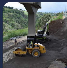
Movimiento de tierras final en Pila 1 Octubre 2024
