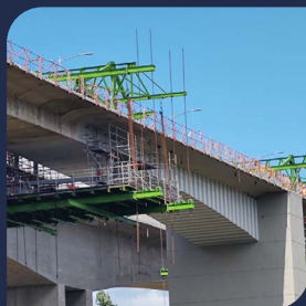
Colocación de fibra de carbono Diciembre 2023
