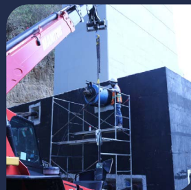
Tensado de cables en cimentación Febrero 2024
