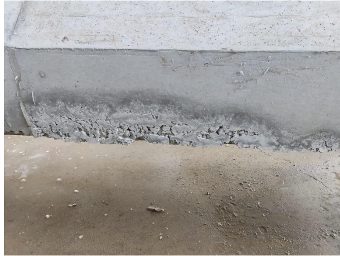
Figura 36. Nidos de piedra en estructuras coladas. Fecha 8 de noviembre de 2023. Fuente: LanammeUCR (la viga 4 de la superestructura 5)
