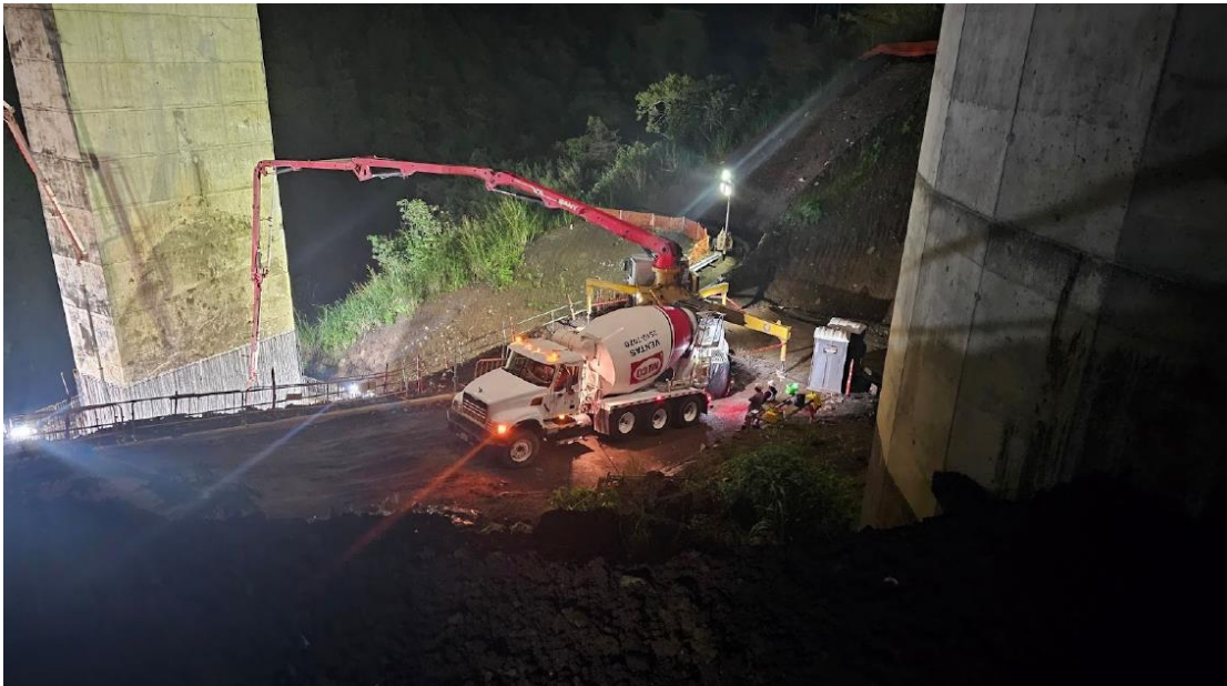
Figura 15. Colocación de concreto en cimentación de pila 3. Fuente: UNOPS, 2023
