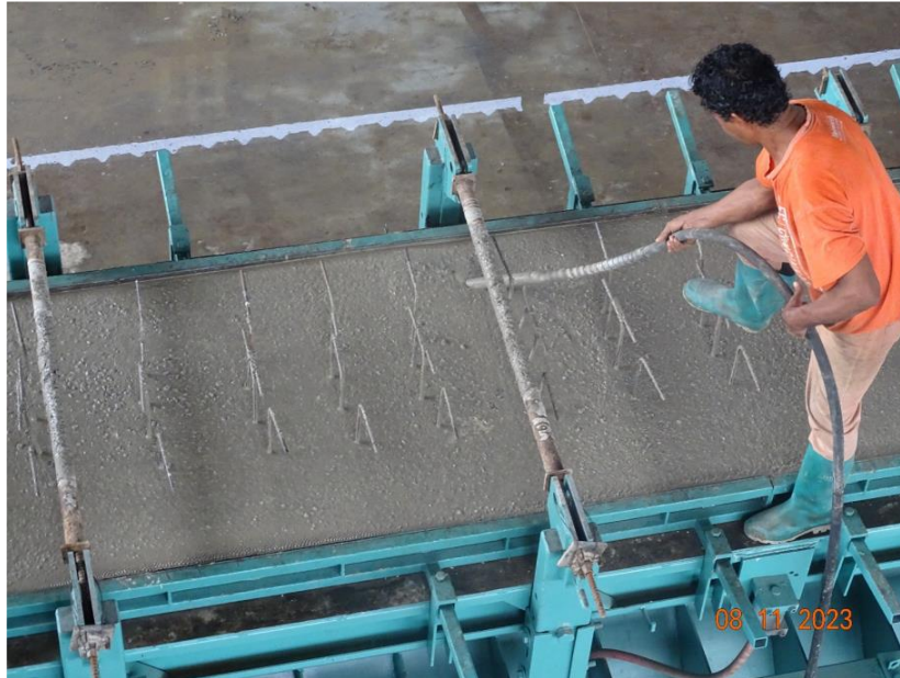
Figura 35. Uso incorrecto del vibrador manual, Fecha 8 de noviembre de 2023, Fuente: LanammeUCR.
