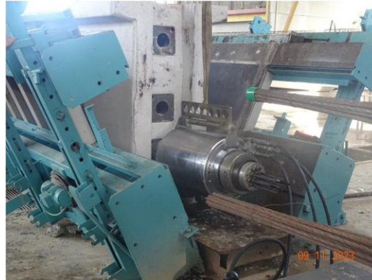
Figura 31. Proceso de tesado de ducto inferior de vigas de superestructura. Fuente: LanammeUCR (2023)
