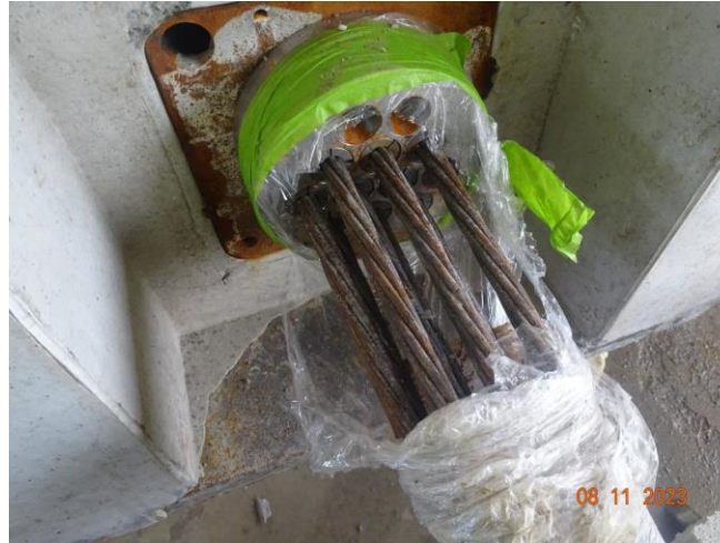
Figura 38. Acero de presfuerzo con corrosión en la viga N°1. Fecha 8 de noviembre de 2023. Fuente: LanammeUCR
