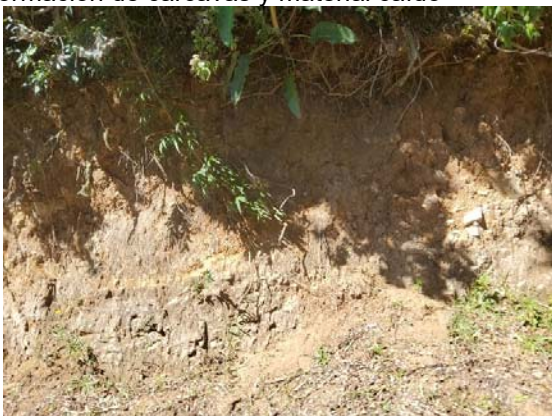
(a) evidencias de erosión en la cara del talud, estación 0+691
