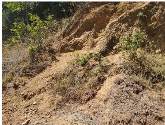
(b) formación de cárcavas y material caído, estación 8+362
