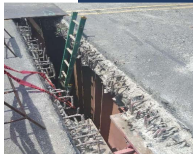
Trabajos en pila 4
