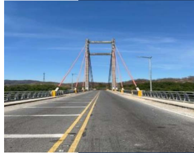
Inicio de trabajos A1, P 4 y 8
