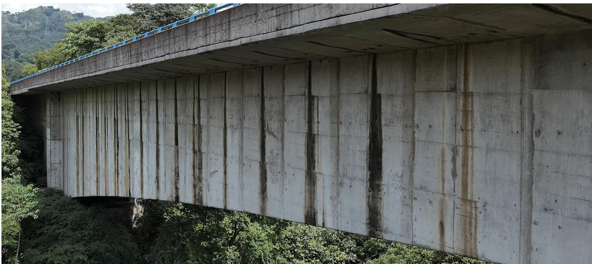
Figura 4.3. Vista lateral del costado aguas arriba del puente
